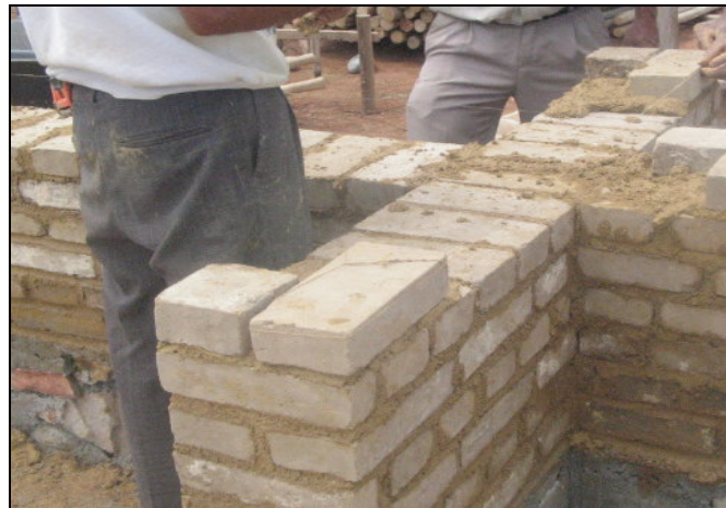
Figura 169. Levantamientos de los muros. Fuente: Autores del proyecto.
