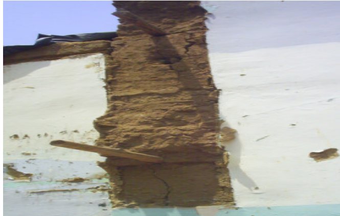
Figura 69. Trabe con madera Rolliza. Fuente: Autores del proyecto.
