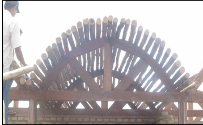
Figura 170. Colocación de la madera rolliza para la cubierta. Fuente: Autores del proyecto.
