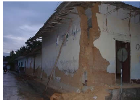
Figura 73. Efectos de los sismos en construcciones de tierra. Fuente: www.lamasperu.com/información/terremoto.htm
