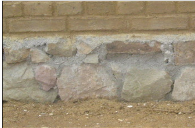
Figura 166. Cimentación. Fuente: Autores del proyecto.
