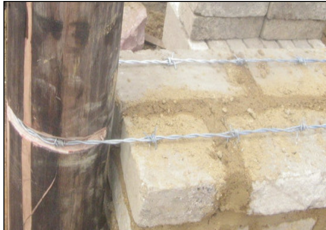
Figura 168. Alambre para la resistencia sísmica. Fuente: Autores del proyecto.
