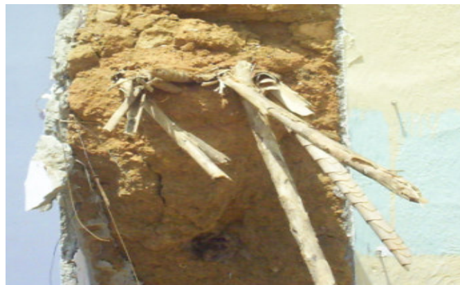
Figura 70. Trabe con caña brava. Fuente: Autores del proyecto.
