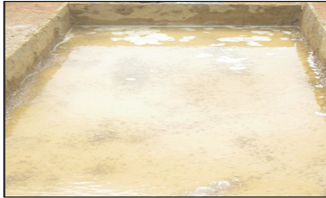
Figura 160. Saturación y reposo de la arcilla de pega. Fuente: Autores del proyecto.
