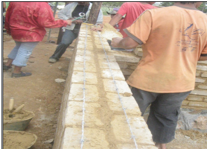
Figura 167. Colocación del alambre. Fuente: Autores del proyecto.
