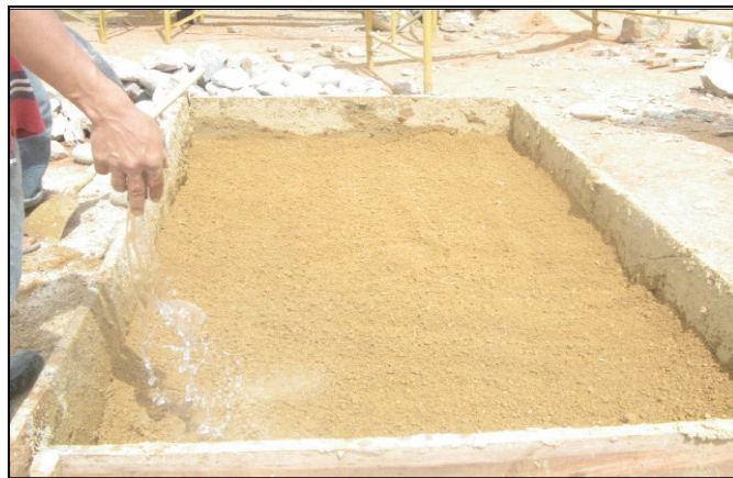
Figura 159. Riego de la arcilla de pega. Fuente: Autores del proyecto
