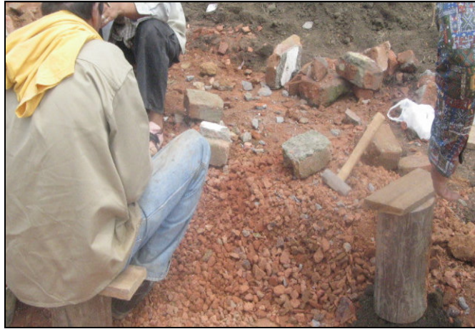
Figura 162. Trituración de ladrillo cosido. Fuente: Autores del proyecto.
