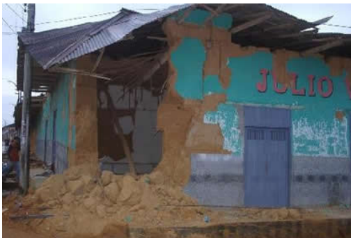
Figura 73. Efectos de los sismos en construcciones de tierra. Fuente: www.lamasperu.com/información/terremoto.htm
