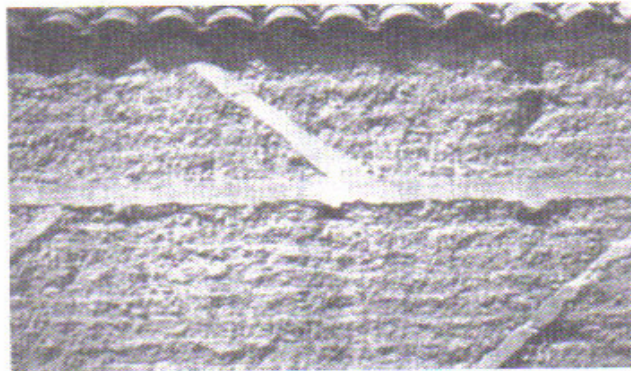
Figura 40. Juntas oblicuas. Fuente: (CRAterre, 1990).
