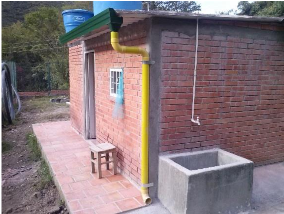
Figura 8. Visita final para recibo de la obra Mejoramiento y mantenimiento infraestructura Instituto Agrícola sede El Aliñadero.
