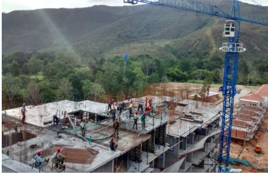
Figura 14. Construcción estructura torre 3 y 4.
