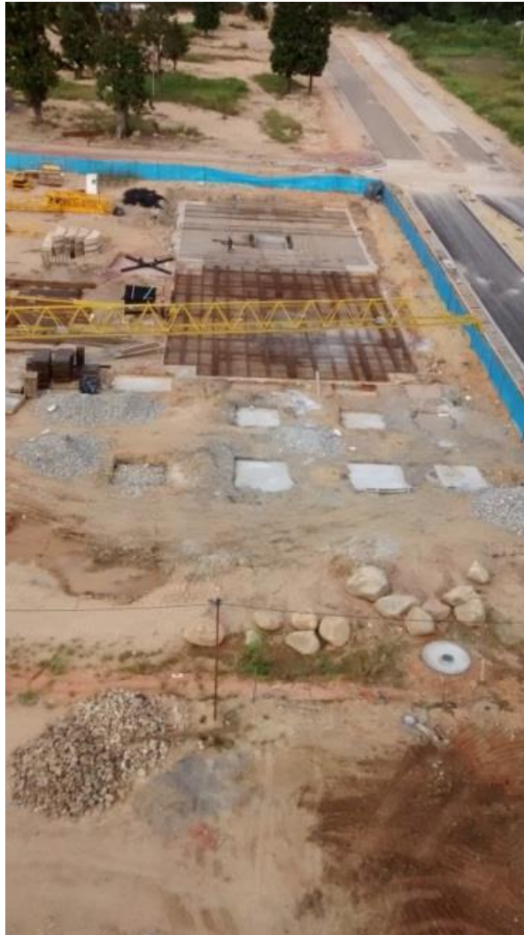
Figura 6. Placa de cimentación y zapatas.
