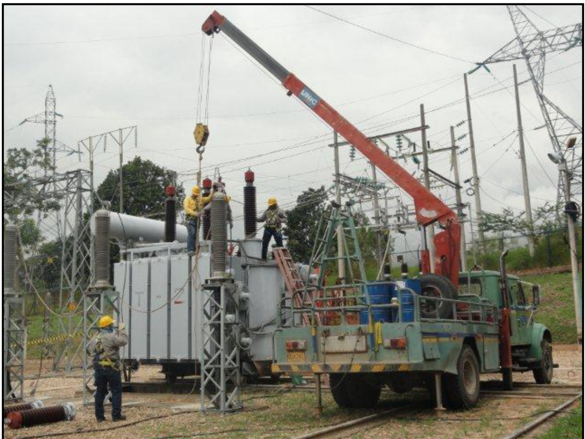
Figura 1. Actividad de montaje y mantenimiento de una planta eléctrica
