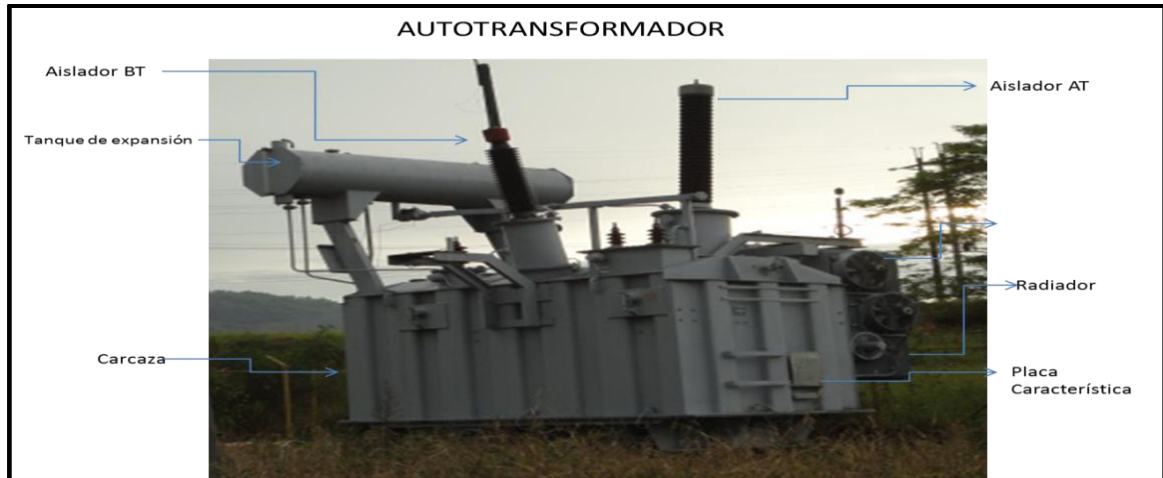
Figura 4. Estructura de un Autotransformador
