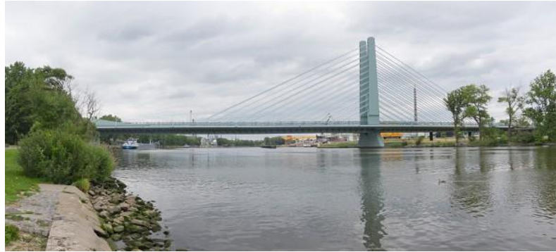
Fig. 4 New Hoechst Bridge, fotografía: Jochen Kratschmer, 2011
