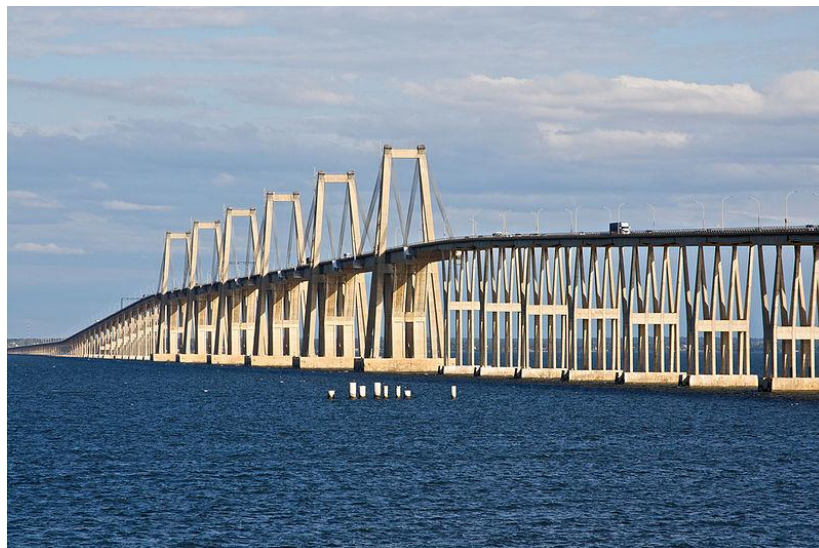
Fig. 5 Puente General Rafael Urdaneta o Puente de Maracaibo. Fotografía: Orlando Pozo ,2008.
