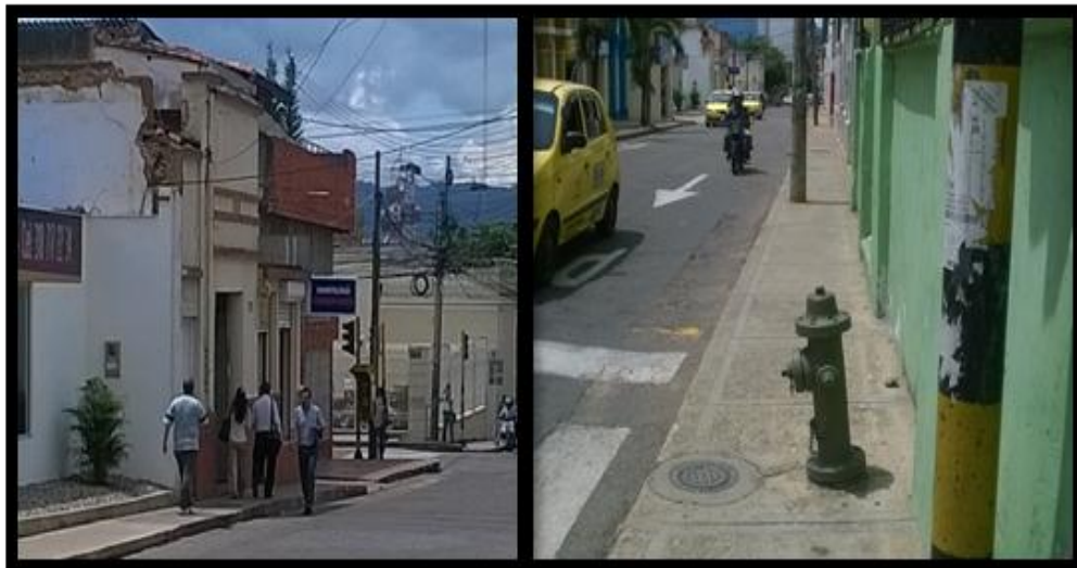
FIGURA 9: Estado actual Cl. 35-21.
