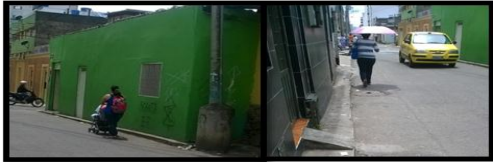
FIGURA6: Estado actual Cr. 23-30
