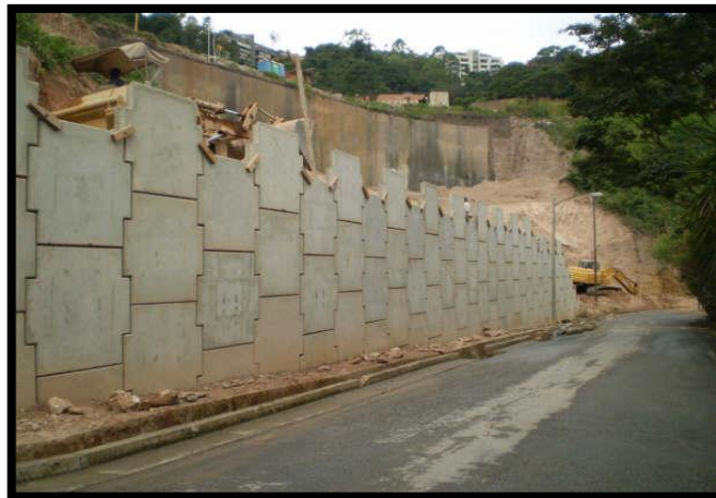
Figura 58: Muro de tierra reforzado
