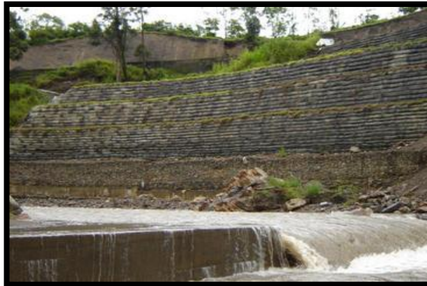
Figura 60: Muro con geotextil
