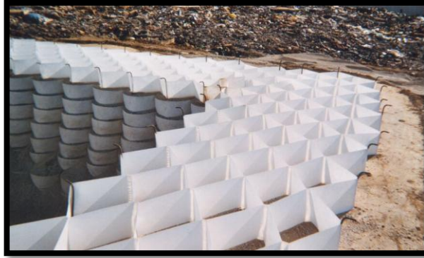
Figura 62: Muro con geomallas
