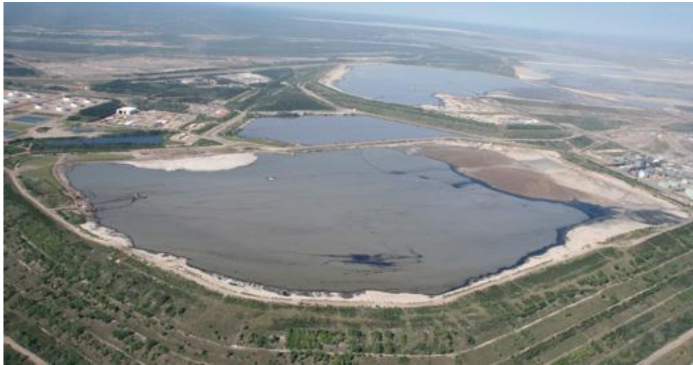
Figura 41. Lagos de depositación sin delimitación en la explotación de arenas bituminosas
