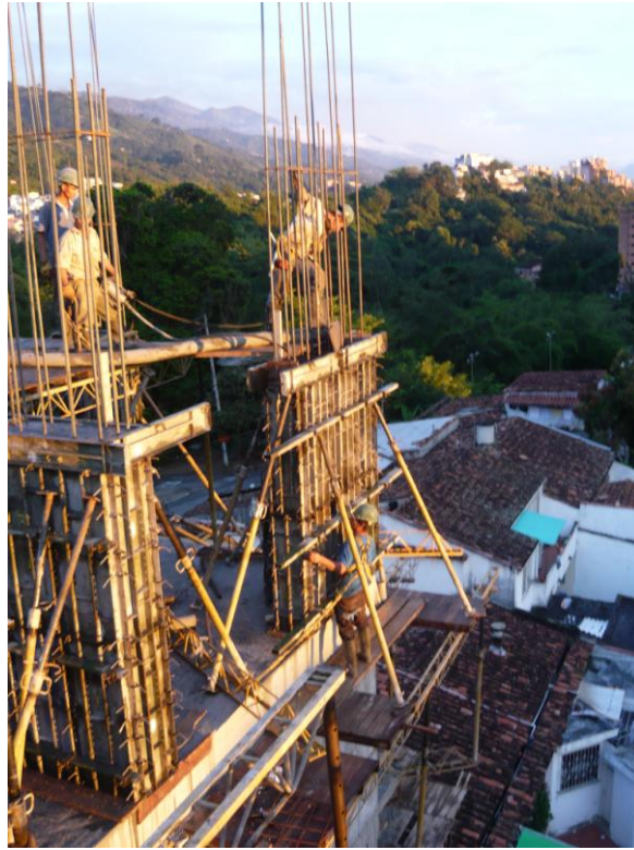
Figura 12. Armada de columnas obra dubai
