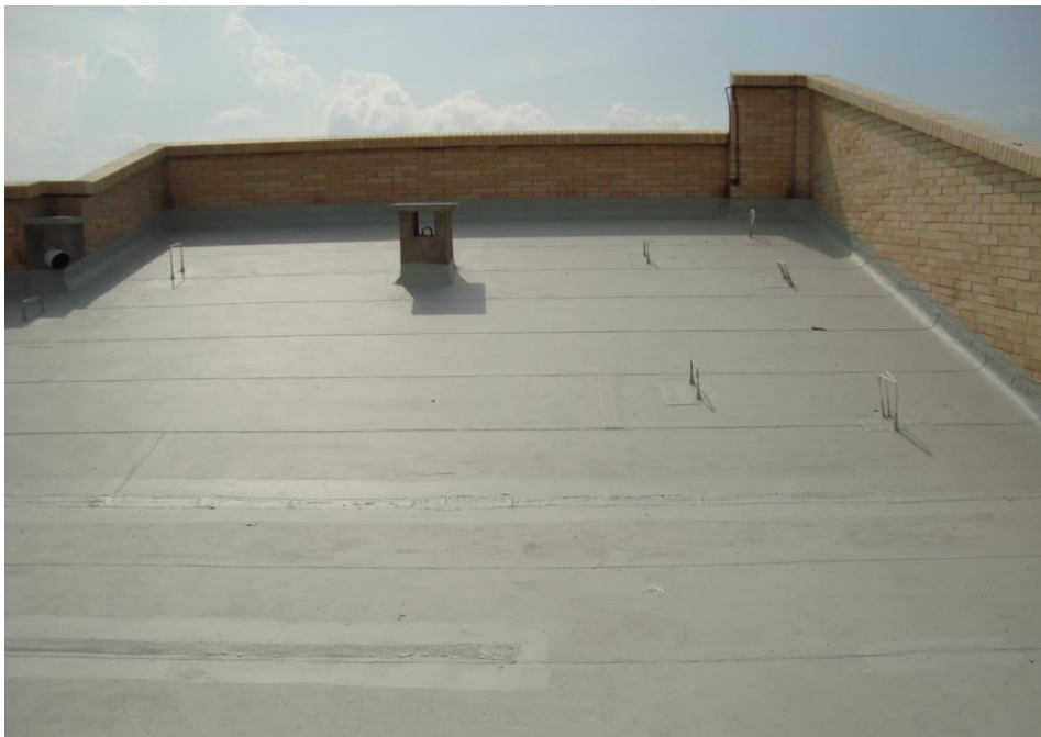
Figura 48. Cubierta inclinada impermeabilizada con manto asfáltico.
