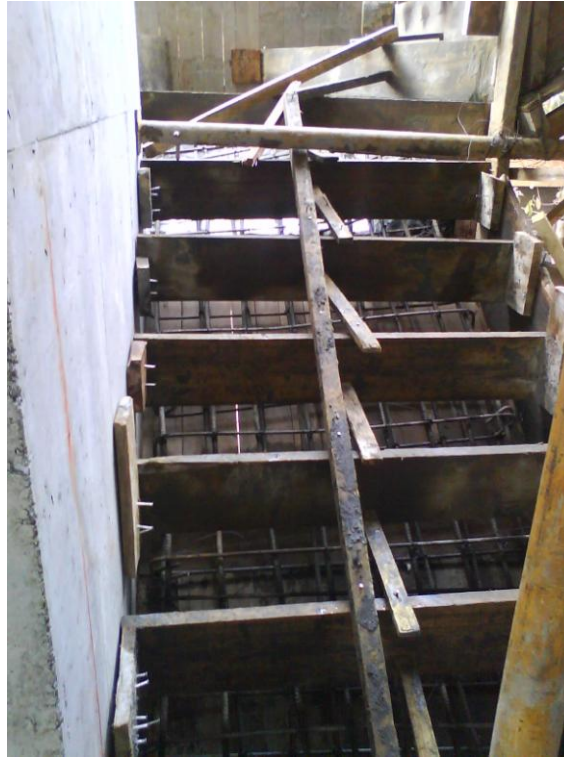
Figura 40. Encofrado de madera para fundida de escaleras.
