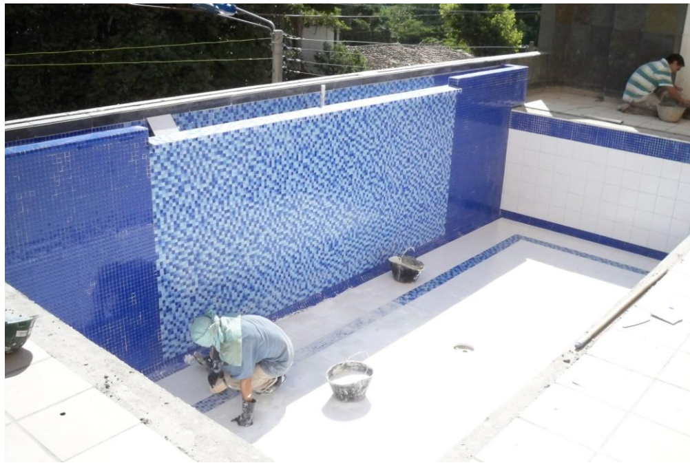
Figura 45. Enchape en cristanac de la piscina de Dubai condominio
