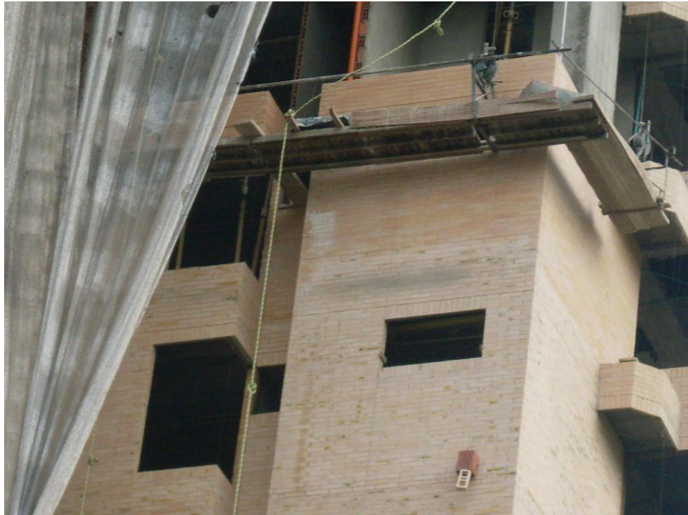
Figura 33. Mampostead a de ladrillo de fachada
