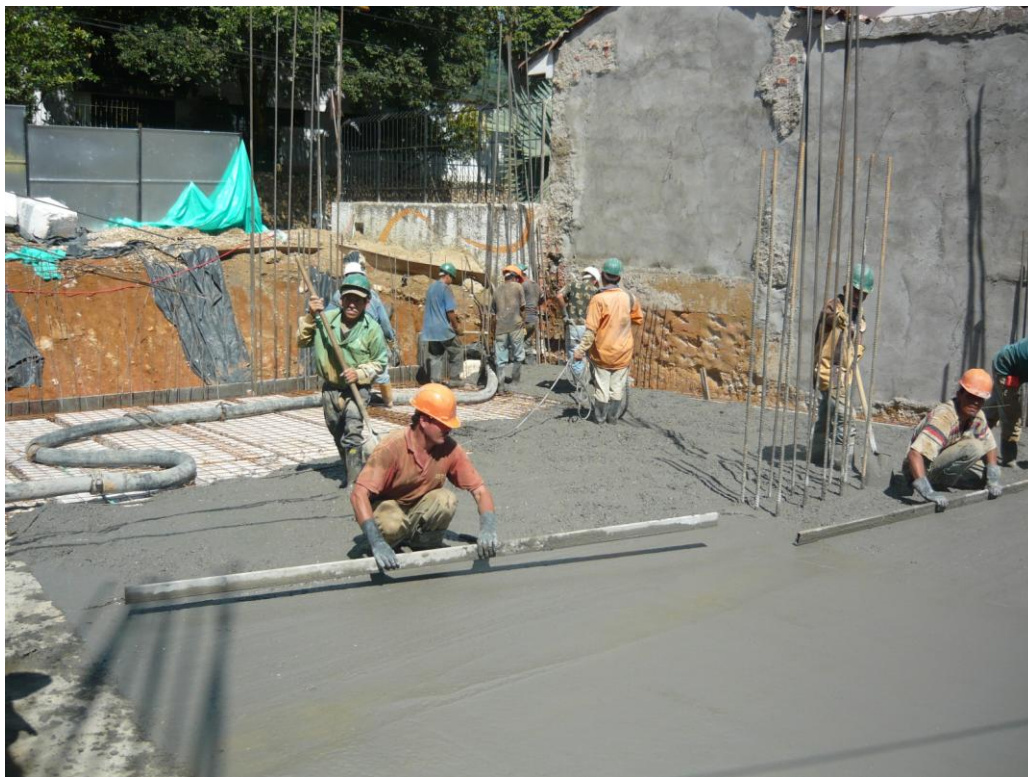
Figura 28. Fundida de placa con bomba estacionaria.
