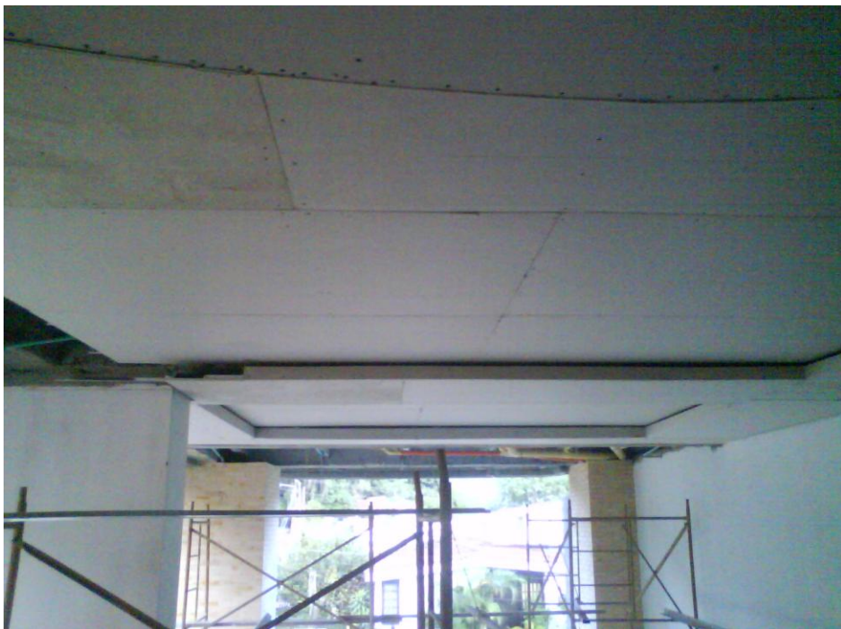
Figura 47. Laminas de drywall instaladas
