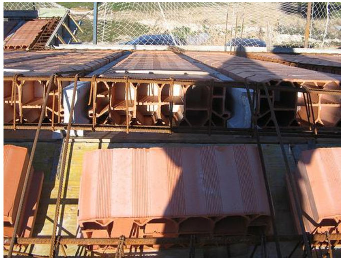
Figura 24. Aligeramiento con labrillos de arcilla
