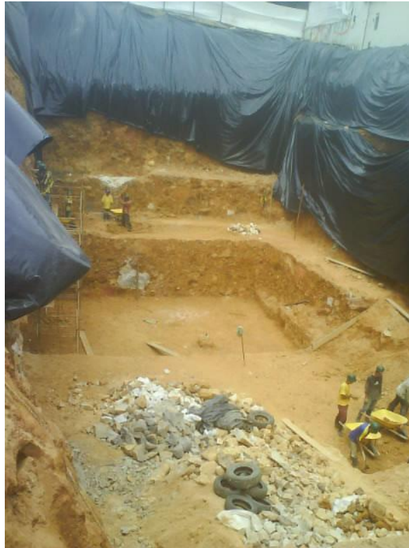
Figura 1. Etapa de excavación del proyecto Dubai 1
