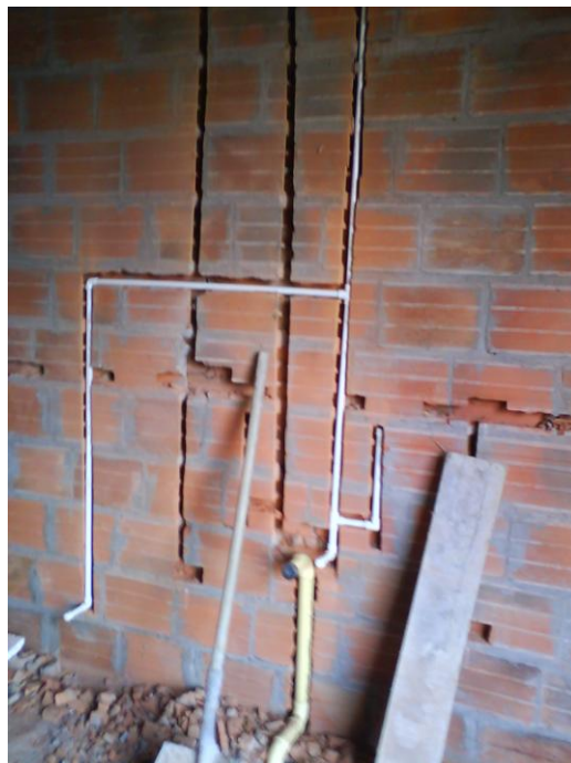
Figura 42. Instalación de agua fría, pendiente instalar la salida de agua caliente
