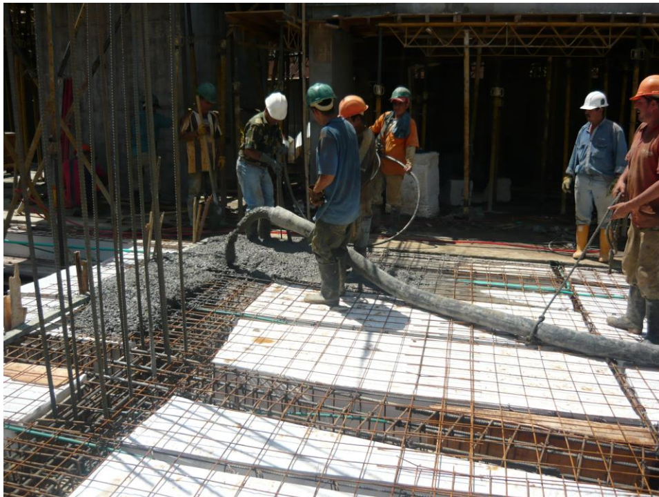
Figura 11. Fundida con bomba estacionaria
