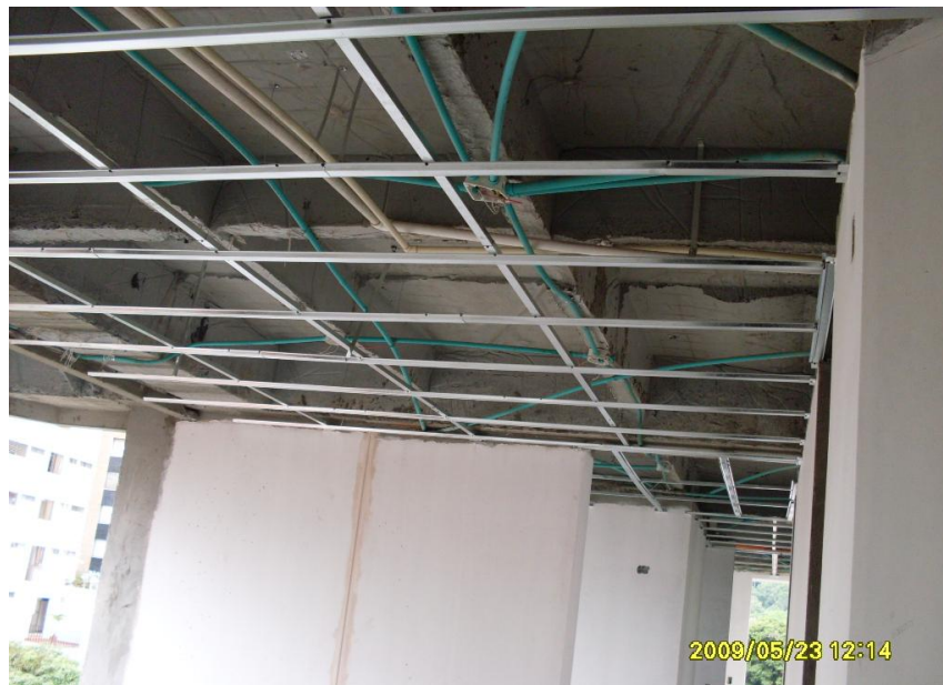
Figura 46. Estructura del cielo raso en drywall
