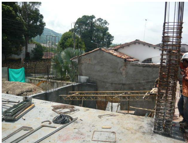
Figura 27. Refuerzos de columnas
