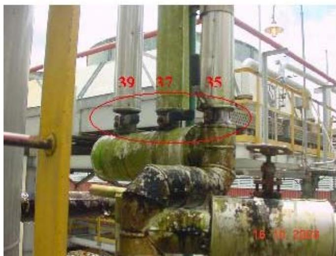
**Figura 16. Válvula neumática para cargue**
