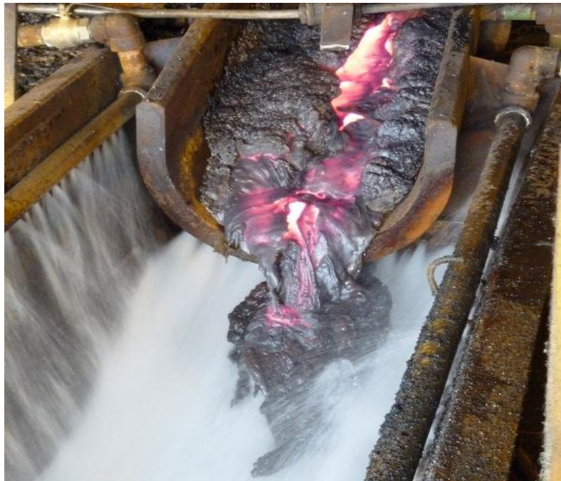
Figura 20. Obstrucción del granulador por costras acumuladas debajo de la canal refrigerada.
