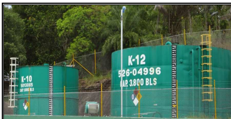
Figura No. 9 Tanques de almacenamiento de agua potable – lavado de filtros.
