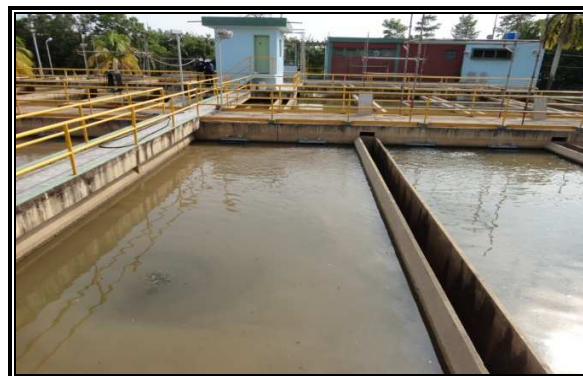
Figura No. 11 Lodos retenidos en los filtros.
