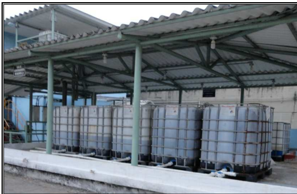
Figura No. 3 Zona de almacenamiento de coagulante
