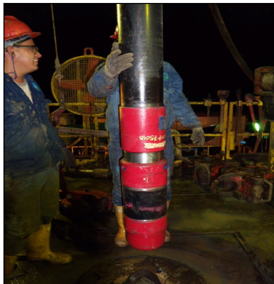
Figura 15. Instalación del Formation Packer Shoe
