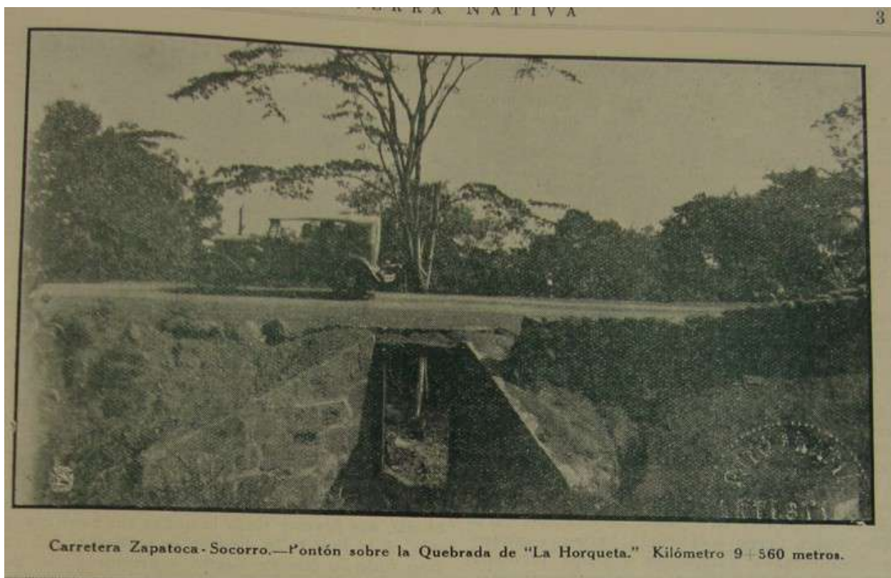
“Carretera Zapatoca – Socorro. – Pontón sobre la Quebrada de La horqueta. Kilómetro 9 – 560 metros.”
