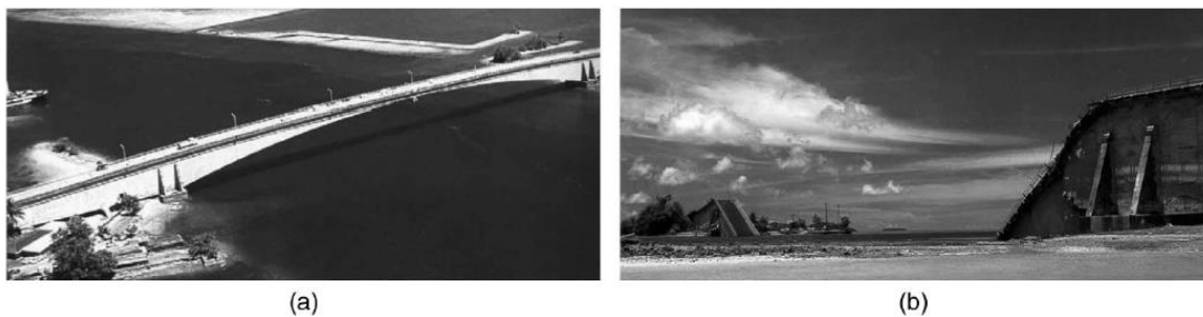
Figura 13. (a) Puente de Koror-Babeldaob en Palaos en 1977; (b) Vista lateral del puente después de su colapso en 1996. [32]
