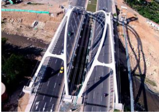
Figura 1. Puentes en arco de concreto sobre el río de Oro, vía Girón-Bucaramanga, Santander, Colombia. [10]
