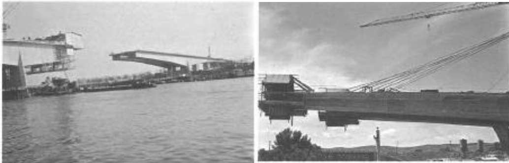
Figura 5. Puente de Balduistein, primer puente construido en el mundo por el procedimiento de avance en voladizo sucesivo realizado in situ. [16]
