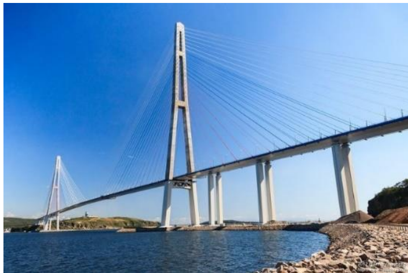
Figura 4. Puente atirantado de la isla Russki sobre el estrecho del Bósforo oriental, Rusia. [13]
