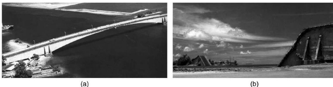
Figura 31. (a) Puente de Koror-Babeldaob en Palaos en 1977; (b) Vista lateral del puente después de su colapso en 1996. [13]
