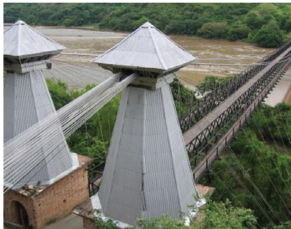
Figura 3. Puente de Occidente, Departamento de Antioquia, Colombia.
