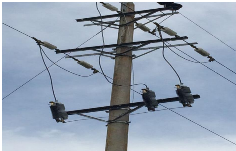
Figura 22. Instalación de DPS cada 500 metros circuito Garzas
