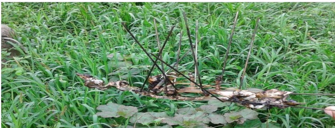
Figura 35. Elemento Bird Repellent, Púas Anti Pájaros retirado después de la falla
