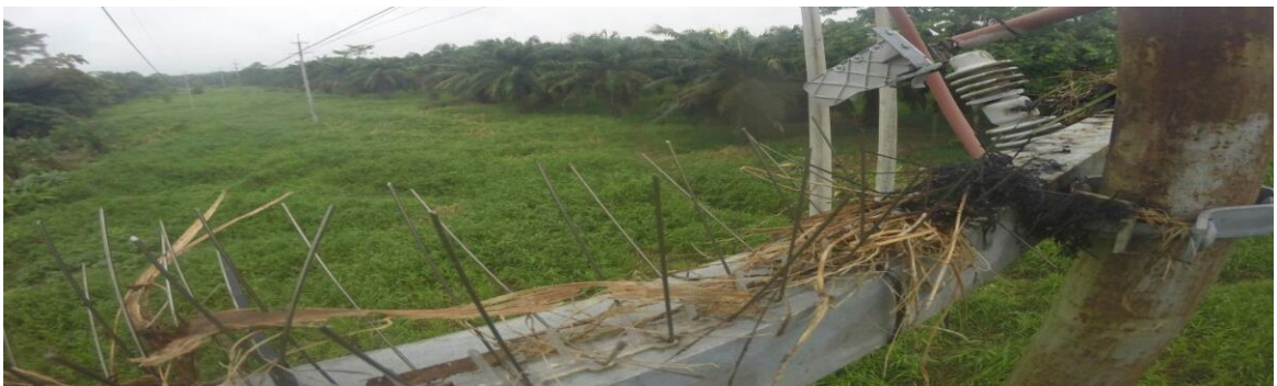
Figura 34. Falla ocasionada por Bird Repellent, Púas Anti Pájaros
