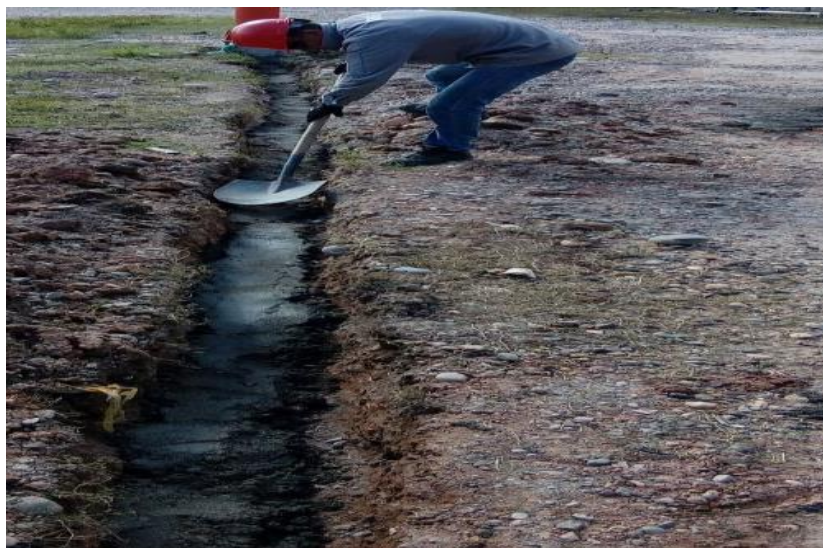
Figura 21. Instalación de los electrodos de tierra con cemento conductor circuito Garzas
