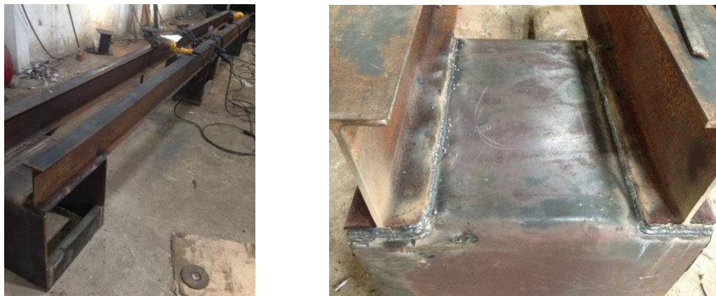
Figura 71. Estructura base montada por completo.
