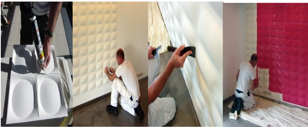
Gráfica 28. Aplicación de adhesivo al panel de bambú
