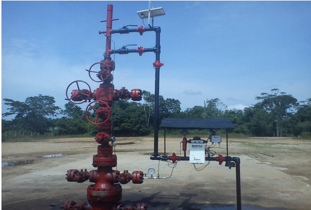
Figura 6. Instalación equipos de superficie sistema Plunger Lift
