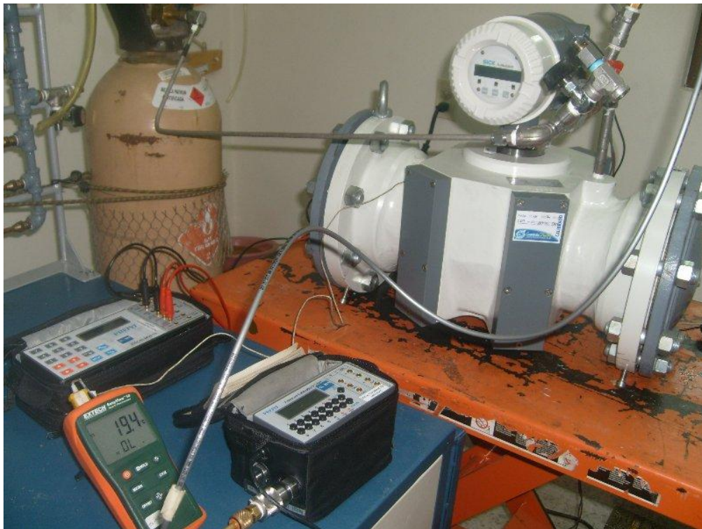
Figura 22. Prueba Experimental de Flujo Cero con Gas Natural
