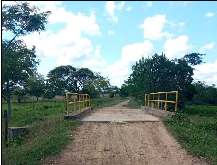
Figura 18. Puente en concreto en buen estado.
