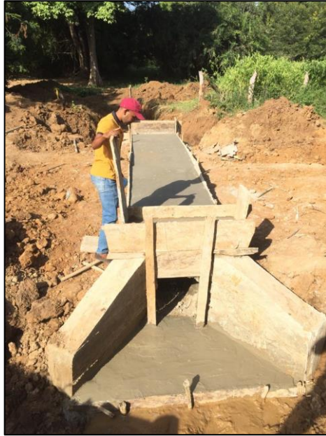
Figura 14. Fundición placa superior.
