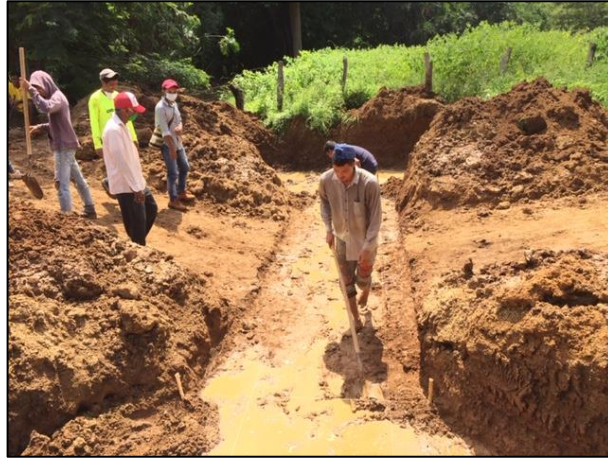
Figura 12. Excavación manual, construcción Box-Culvert.
