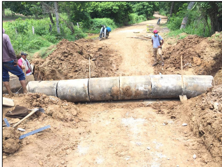
Figura 13. Instalación de anillos en concreto reforzado.
