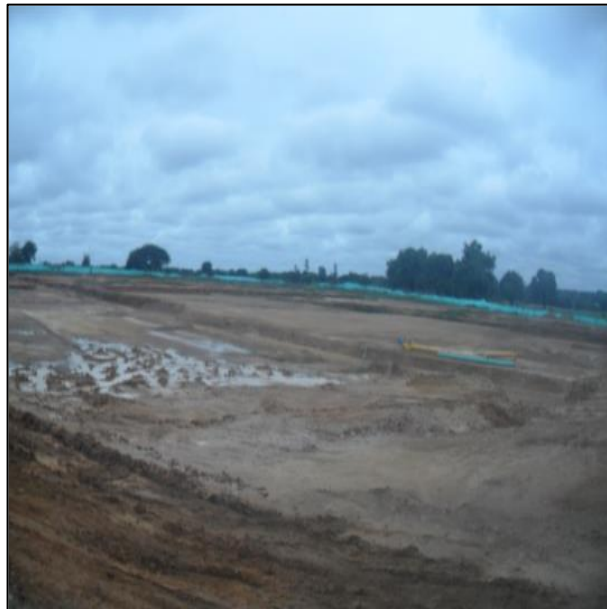
Figura 2. Excavaciones y relleno, urbanización San Antonio de Padua
