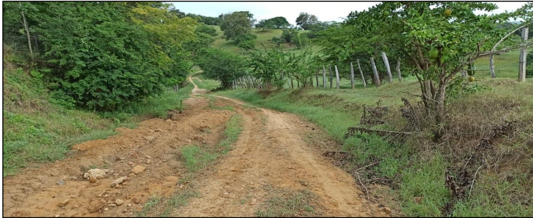
Figura 16. Tramo critico # 5, vía Astrea – La Siria – Montebello
