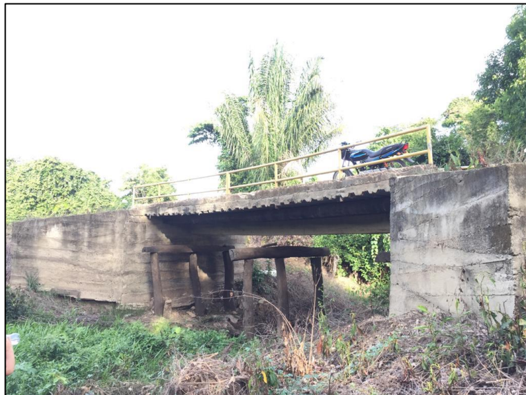
Figura 19. Puente en concreto en regular estado.
