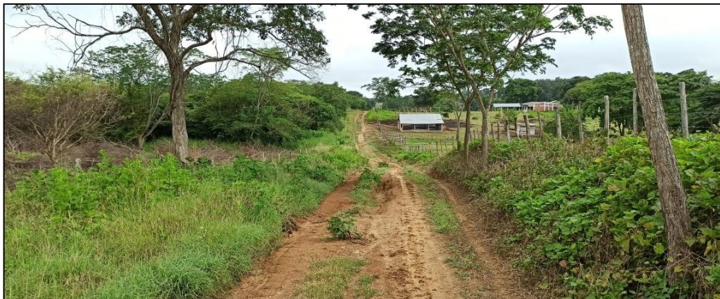
Figura 17. Tramo critico # 6, vía Astrea – La Siria – Montebello
