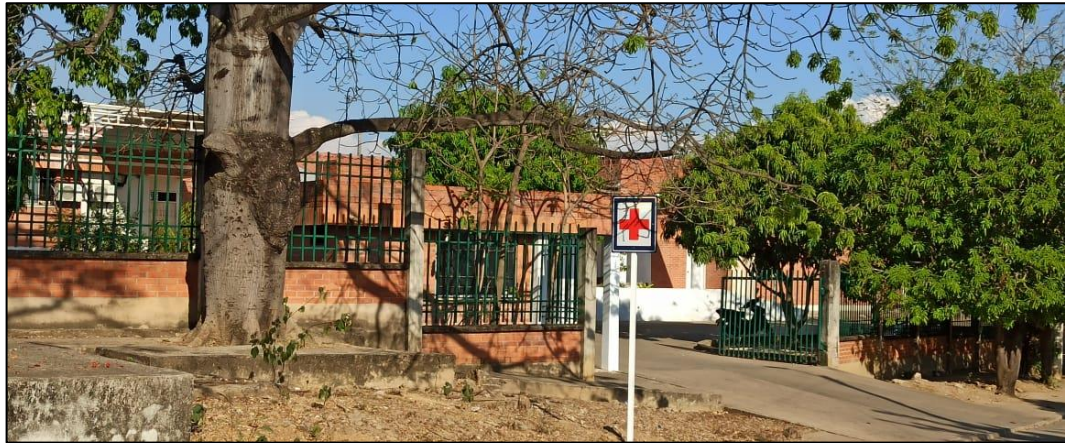
Figura 28. Señalización Hospital San Martín de Astrea.
