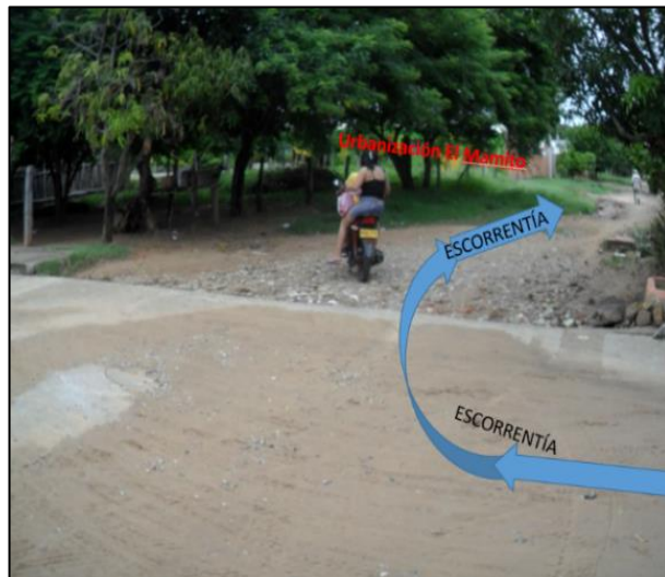
Figura 6. Escorrentía de carrera 4 a calle 2, urbanización el Mamito.
