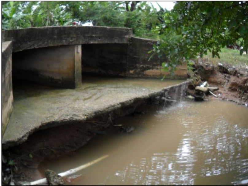
Figura 10. Descole box culvert.
