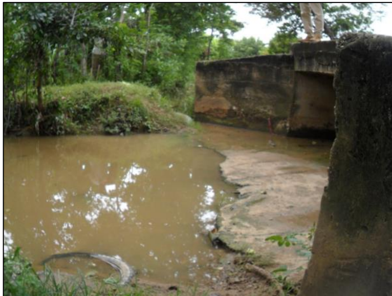
Figura 9. Encole box culvert.
