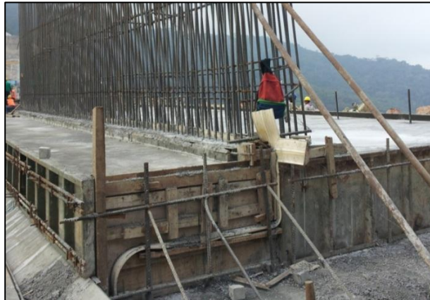
Figura 28. Modificación de formaleta para acople del sello
