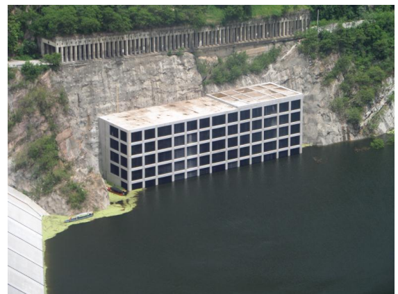
Estructura de Captación - Octubre
