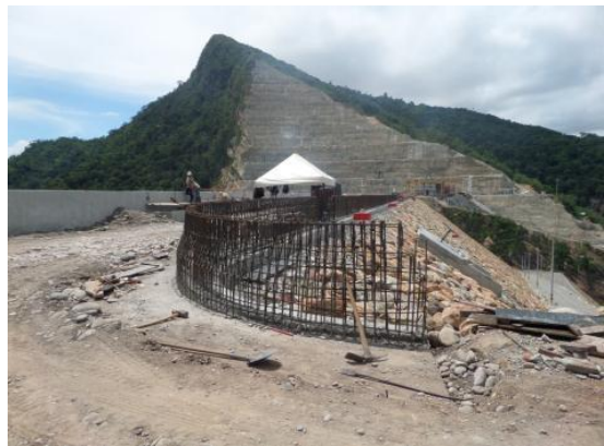
Banco de ductos de la presa - Agosto
