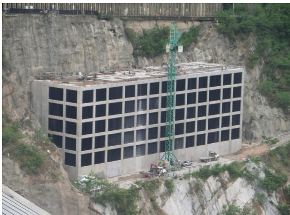
Estructura de Captación - Agosto
