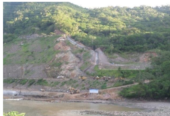
Cuenco Disipador Noviembre
