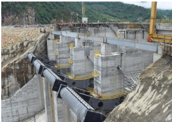
Muros posteriores (pilas) - Agosto
