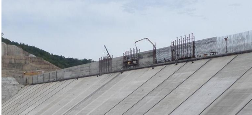
Construcción del muro parapeto en cresta de la presa- Julio
