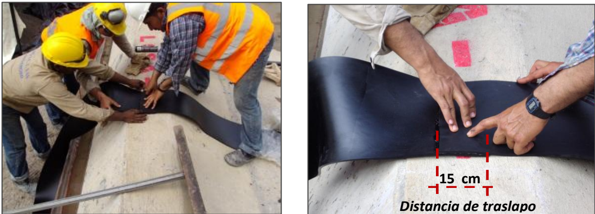
Figura 26. Unión en banda de PVC
