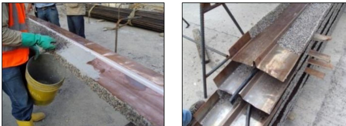
Figura 18. Tratamiento superficie, colocación del relleno de neopreno
