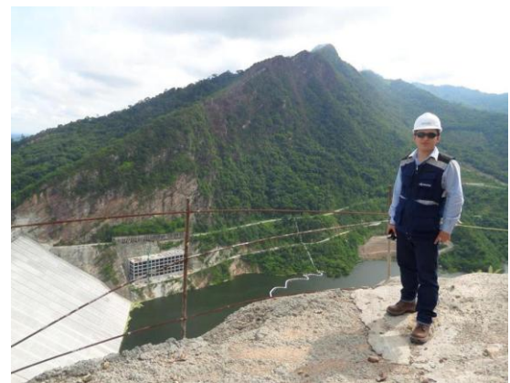
Estructura de Captación – Septiembre
