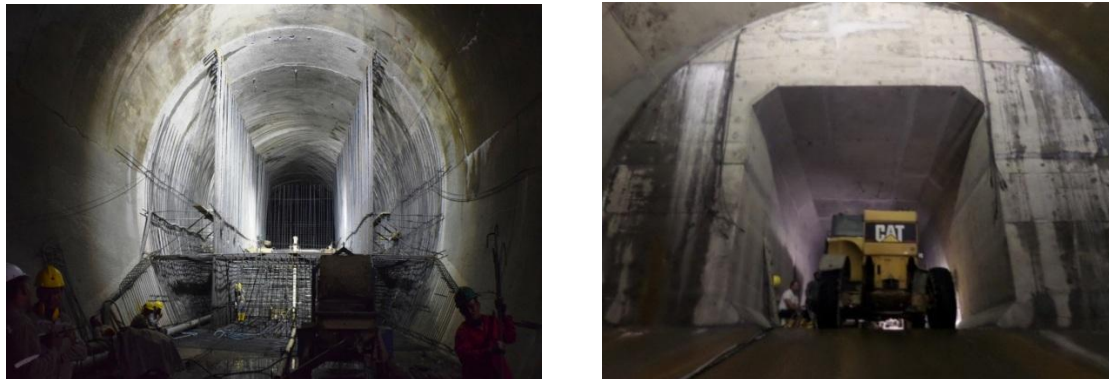
Figura 2. Armado del tapón en túnel de desvío
