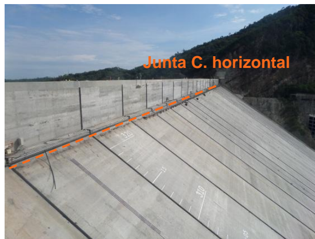
Figura 11. Muro parapeto aguas arriba
