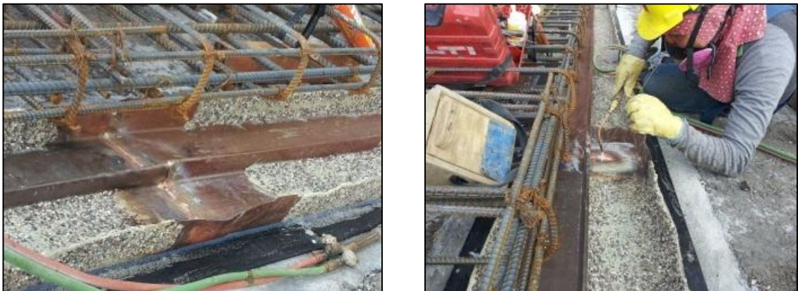
Figura 20. Sello de cobre - soldadura en campo
