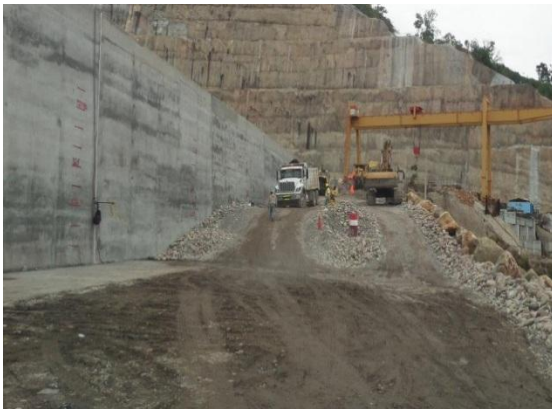
Conformación de llenos zona 3A – Julio
