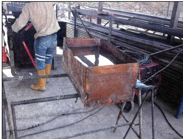
Figura 21. Prueba de estanqueidad en el sello
