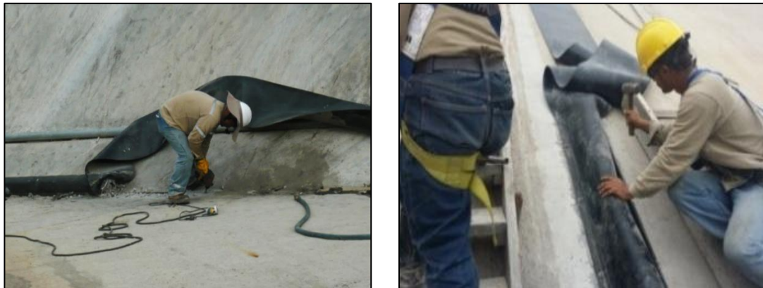
Figura 25. Instalación de pernos
