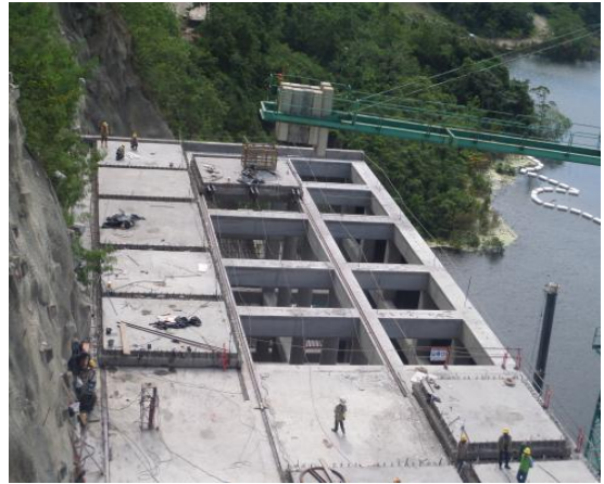
Estructura de Captación - Agosto
