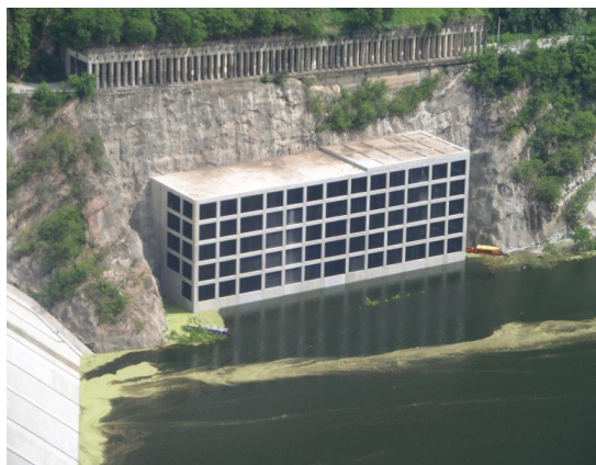
Estructura de Captación - Septiembre
