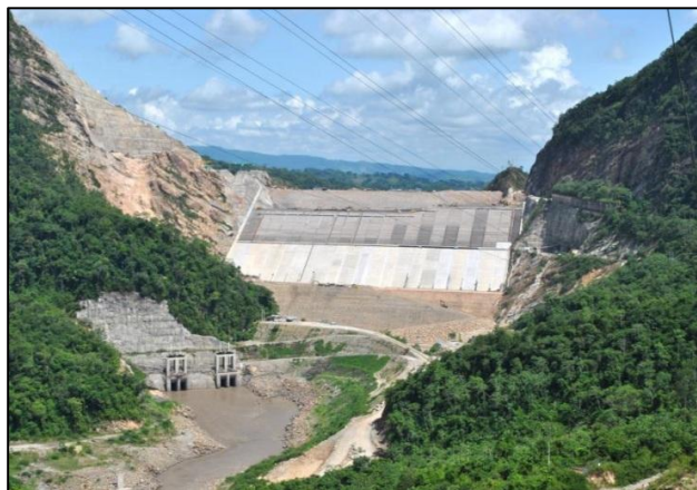
Figura 15. Primera etapa constructiva de la Cara de Concreto
