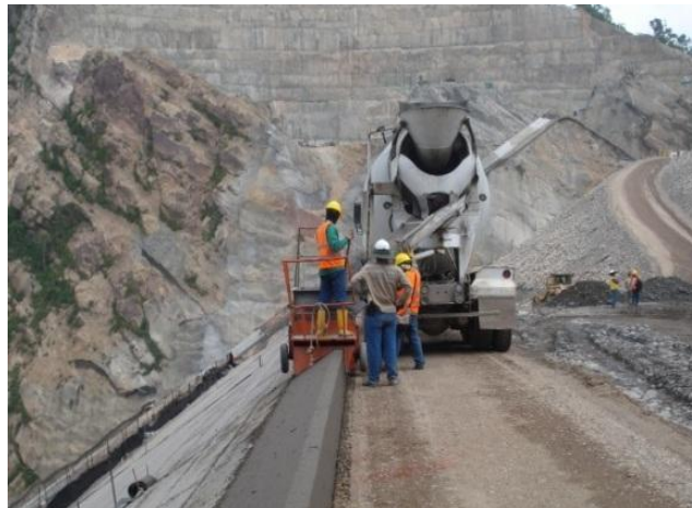
Figura 9. Colocación de bordillo de concreto extruido
