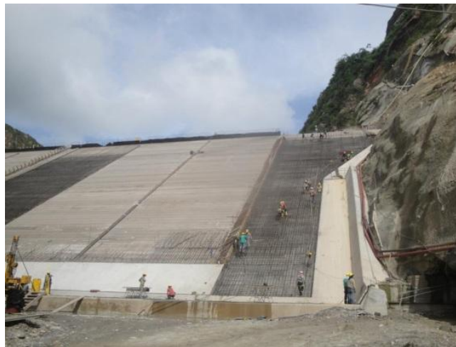
Figura 10. Construcción del plinto de estribo, costado derecho
