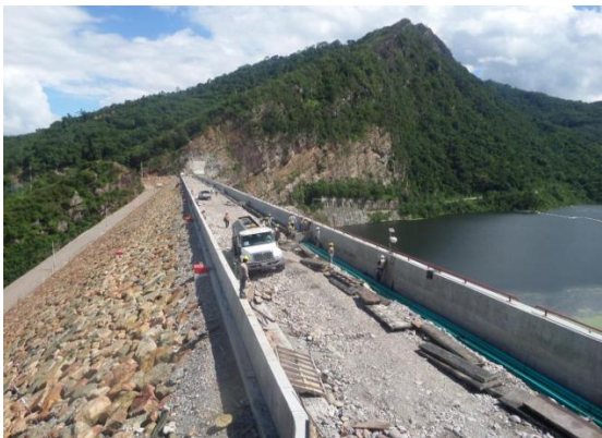
Construcción de bordillos – Octubre
