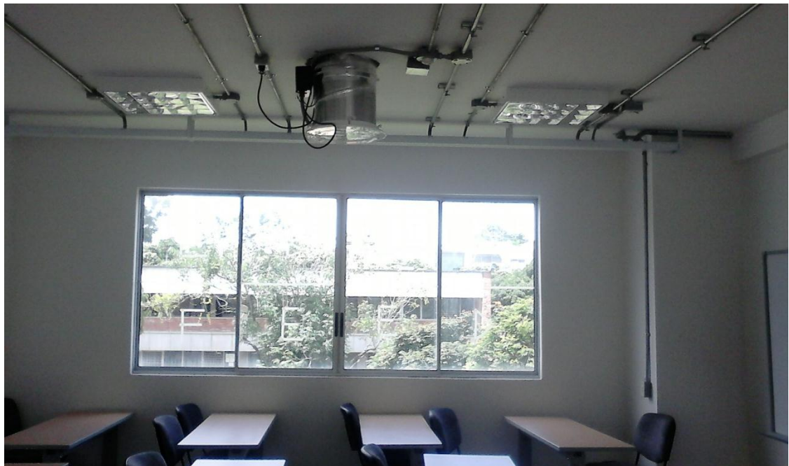
Figura 39. Ventanal pequeño del aula 402 del Edificio de Ingeniería Eléctrica.
