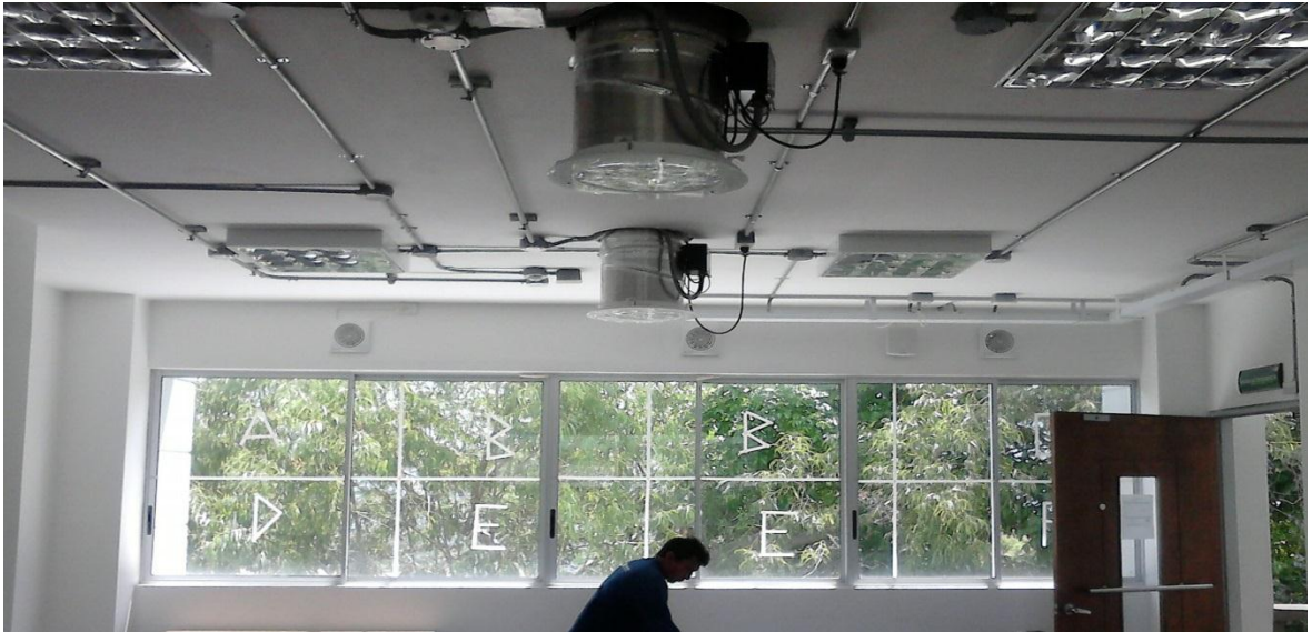
Figura 38. Ventanal grande del aula 402 del Edificio de Ingeniería Eléctrica.
