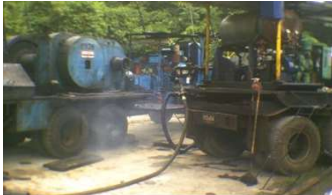
Figura 6. Línea de descarga del calentador
