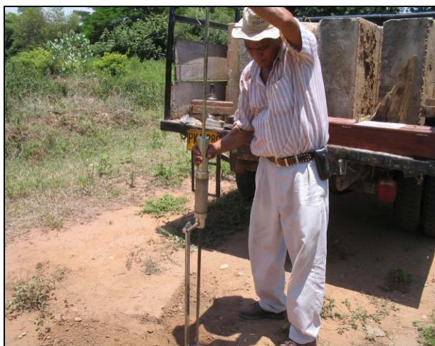
Figura 25. Ensayo de Cono Dinámico de Penetración
