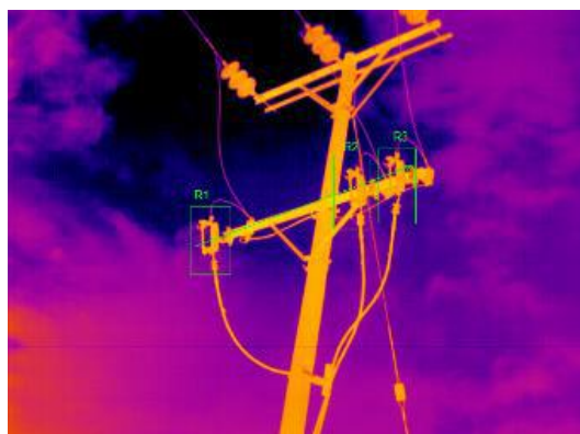
Figura 44. Imágenes por Termografía
