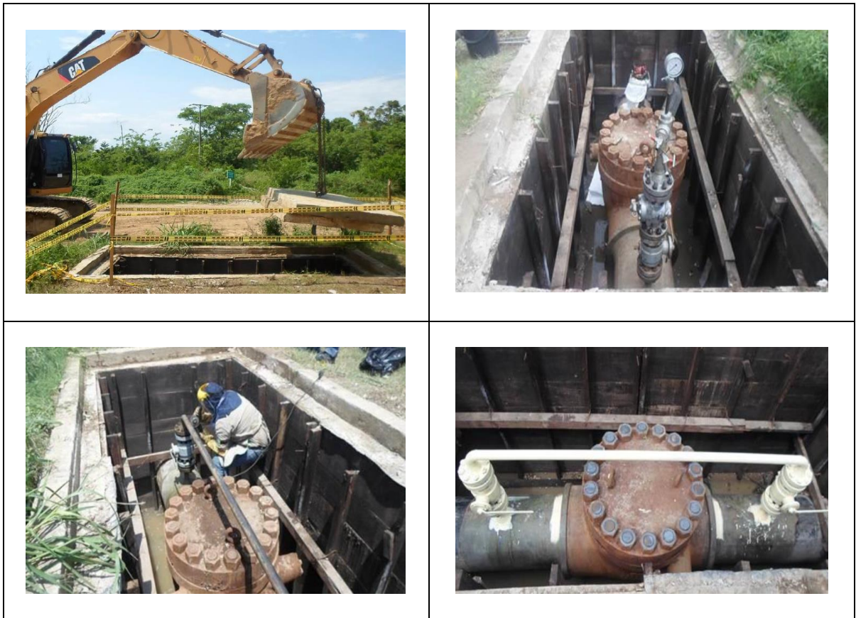
Figura 28. Disposición de Válvulas de Retención OCLC
