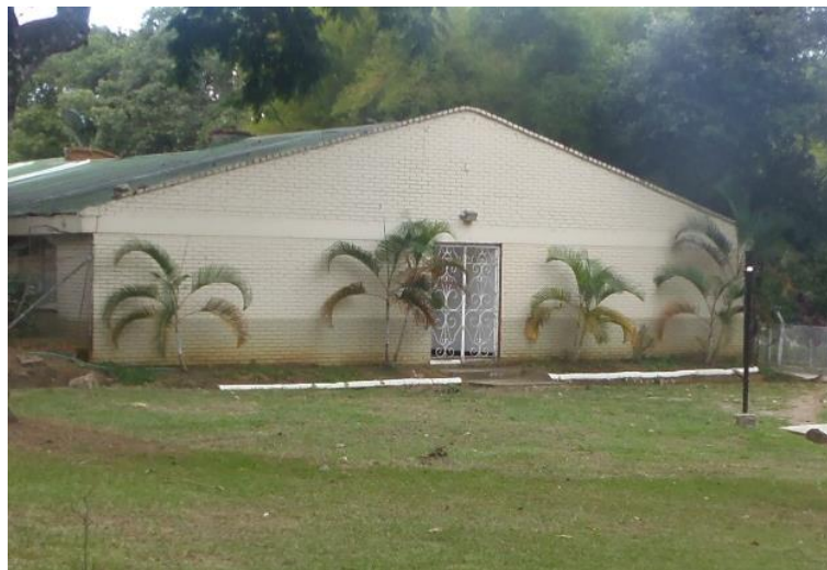
Figura 6. Lugar destinado para construcción de suite.
