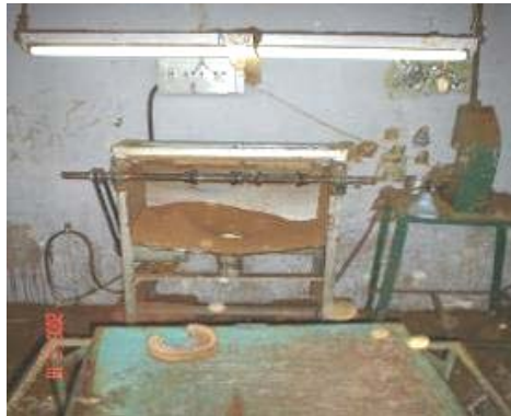
Figura 45. Área de Máquina de terminado desaseada
