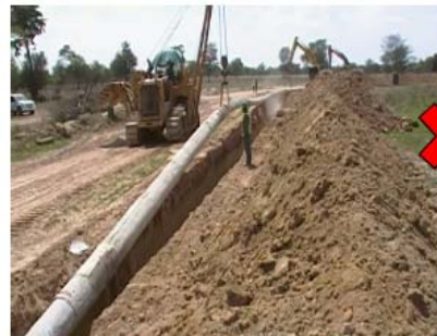
Método de bajado por gravedad empleado por Montecz
