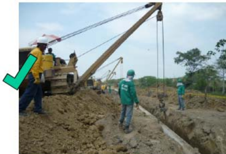
Método de bajado sincronizado con sidebooms en línea
