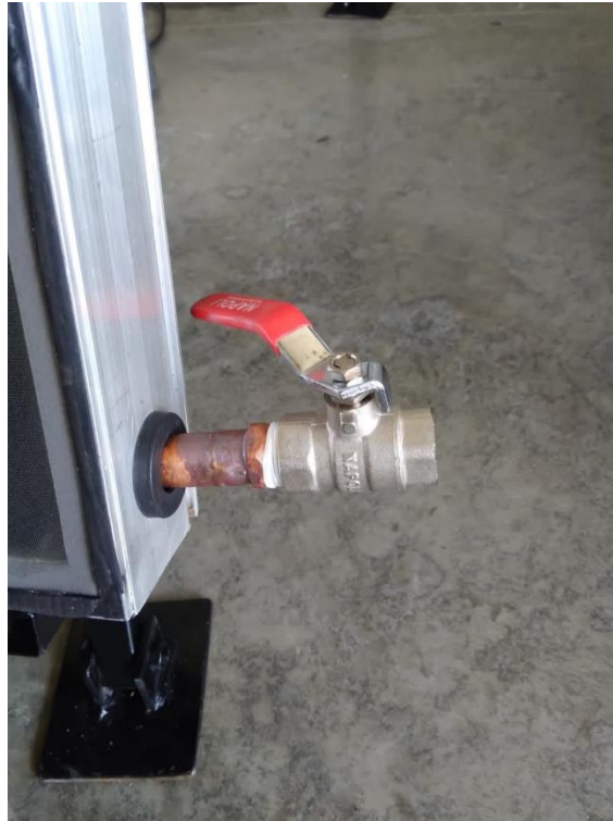
FIGURA 20. Tapón o registro de drenaje.
