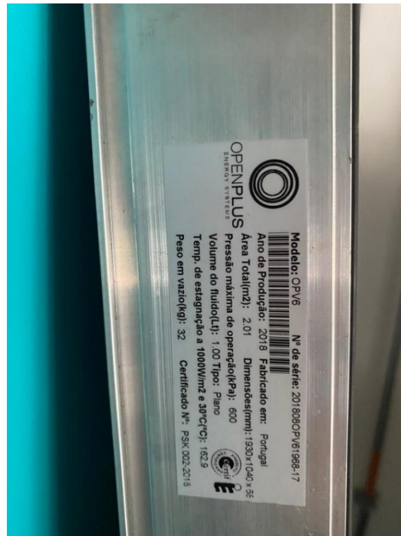
FIGURA 29. Especificaciones del colector solar de placa plana.
