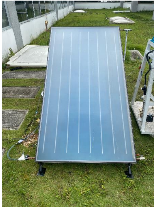
FIGURA 12. Instalación del colector solar de placa plana.
