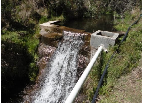
Figura 1. Estructura de captación
