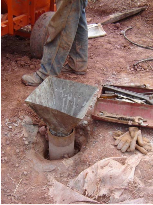
Ilustración 25. Vaciado del concreto.
