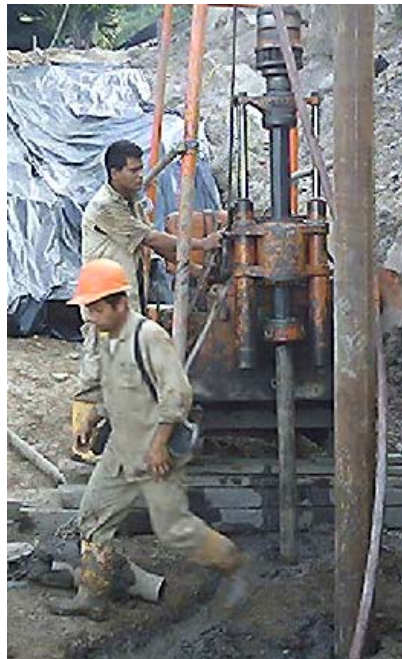
Ilustración 22. perforación para pilote.
