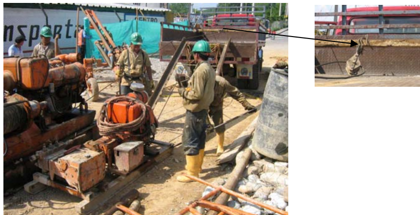
Ilustración 20. Transporte y ubicación de los equipos de perforación.
