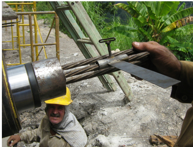
Ilustración 37. Montaje de la reglilla de referencia de elongacion
