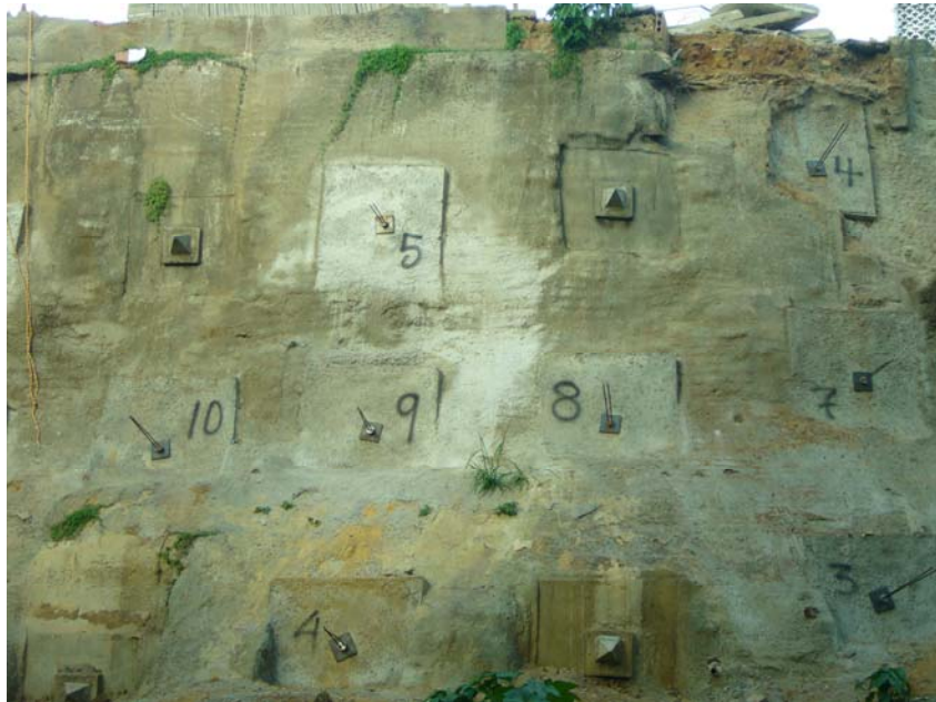
Ilustración 34. Pantalla anclada (Vivero Nazaret, Bucaramanga)
