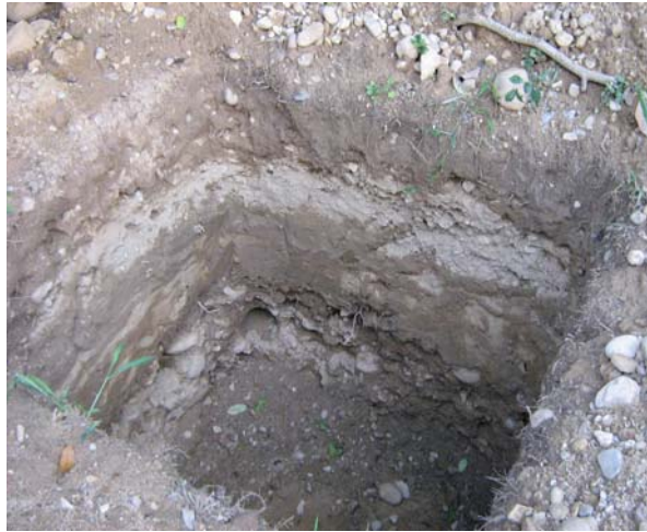
Ilustración 4. Excavación a cielo abierto
