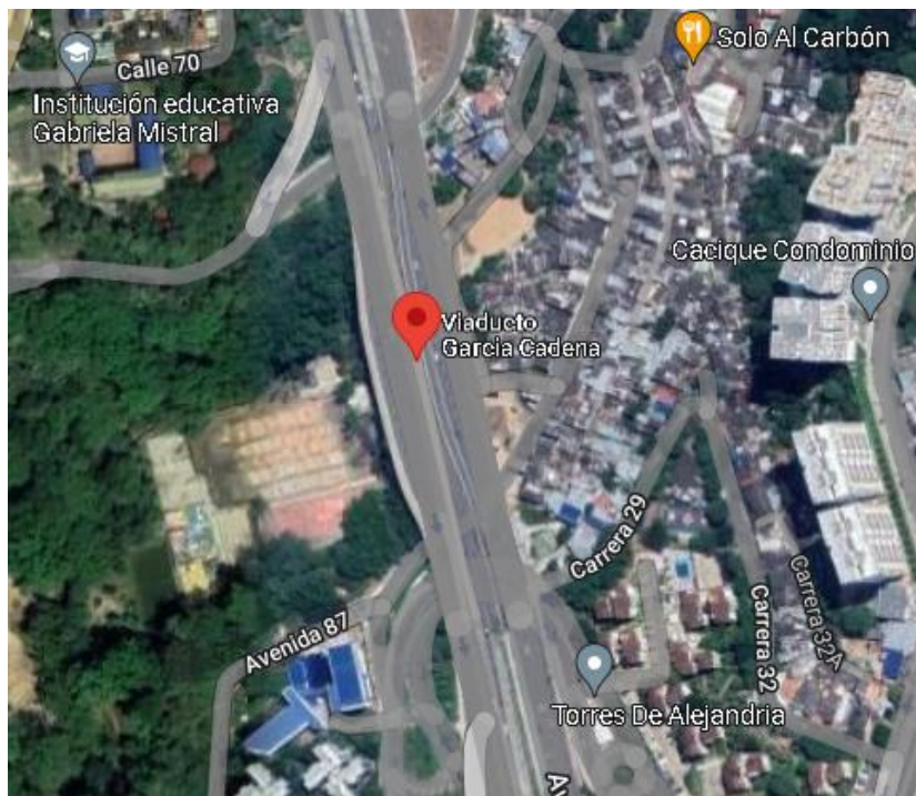
Figura 4. Viaducto García Cadena.
