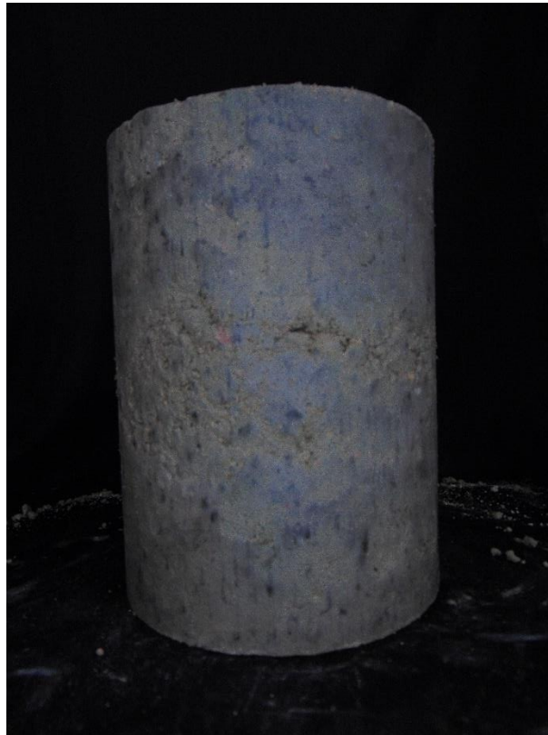
Figura M17. Probeta con humedad de 11.73% - toma lateral
