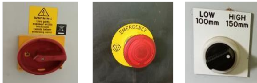
Figura B11. Botón OFF/ON, botón de emergencia, Perilla (150mm)
