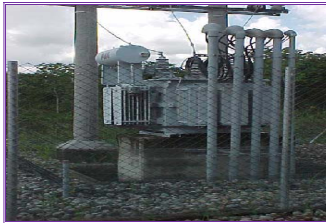
Foto 11. Transformador reductor.
