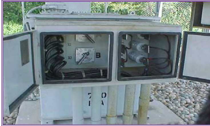
Foto 10. Transformador elevador
