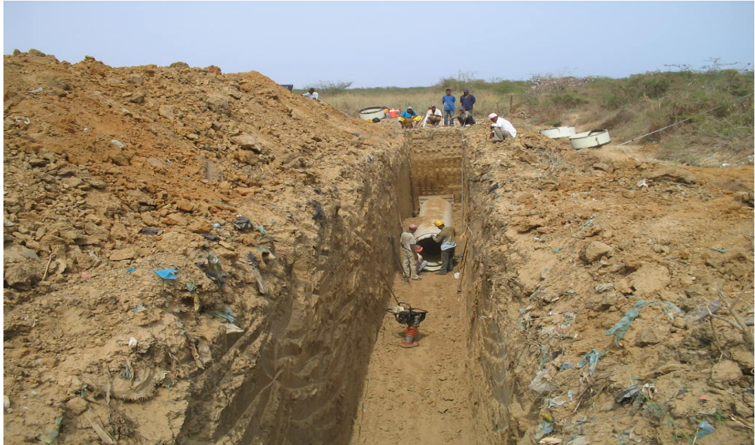
Anexo C. Base compactada – empalme de tubería novafort
