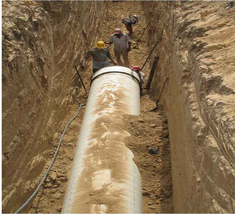
Anexo E. Compactación lateral y colocación de unión
