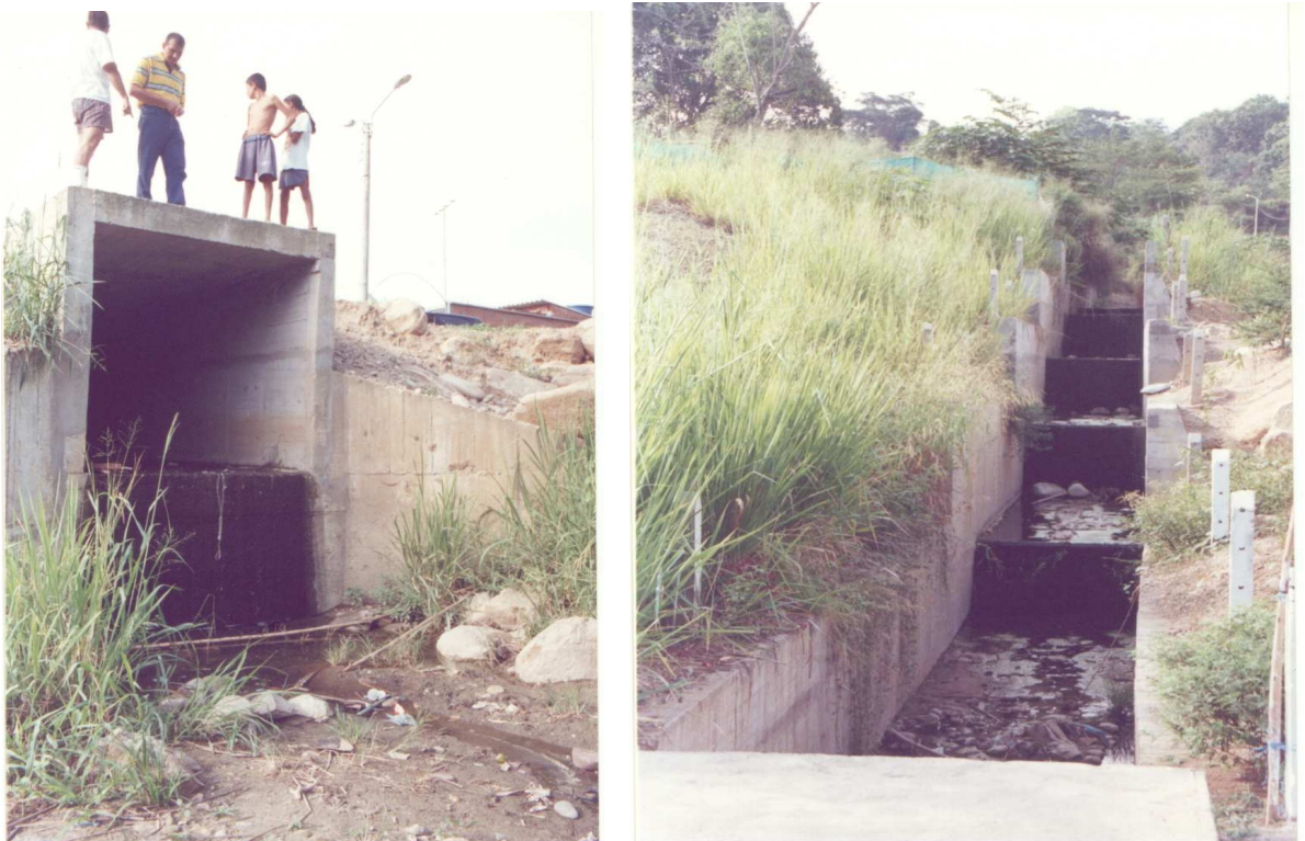
Foto No. 9 Detalle de la canalización de la cañada las Olas que desemboca en el río Surata
