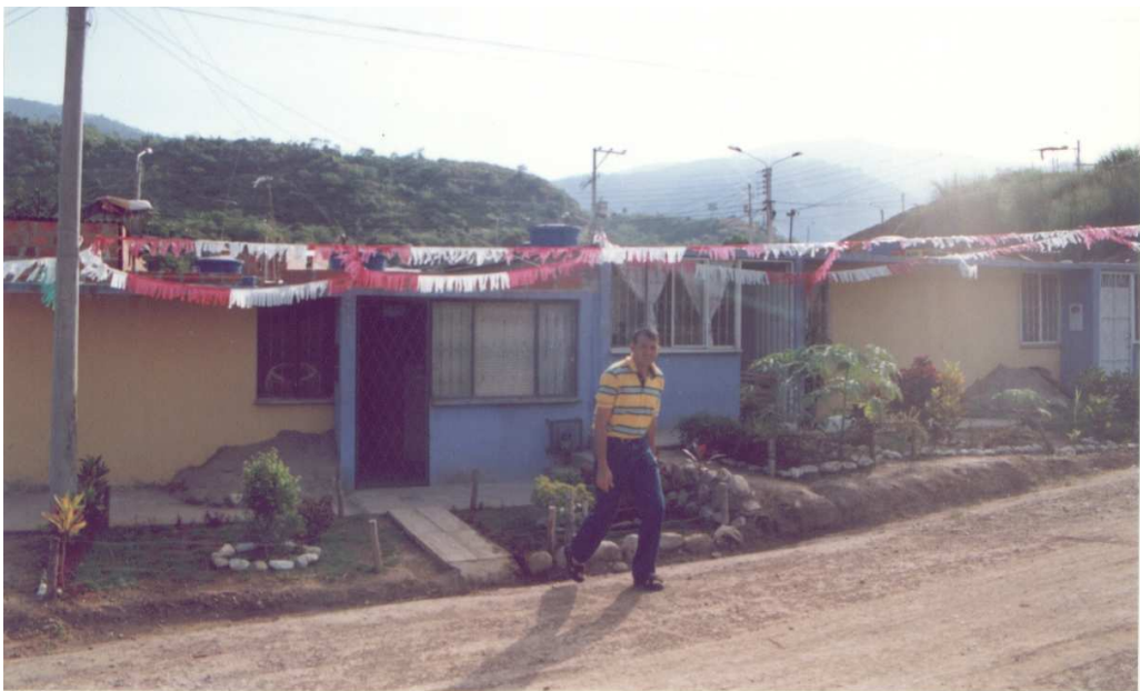
Foto No. 4 Fachada al occidente (escuela y templo) de las viviendas construidas en primer piso, andes, zona verde y calzada.
