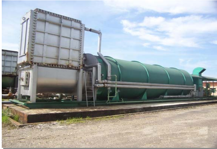
Figura 22. Generador de vapor de paso único
