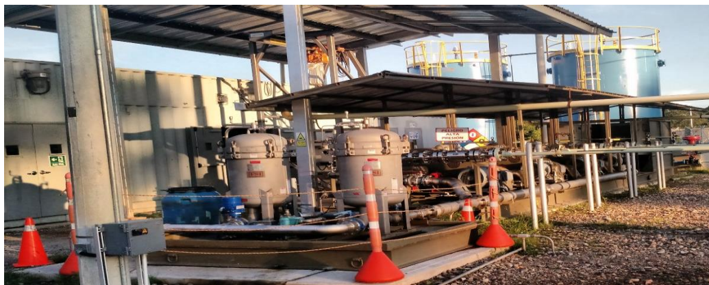
Figura 29. Patín de filtración final.
