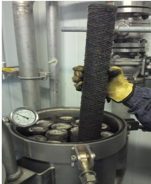
Figura 65. Retiro de elementos filtrantes del filtro principal de agua
