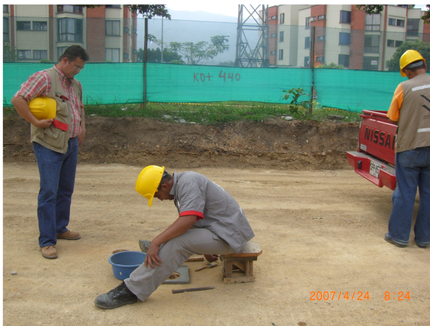
FIGURA 4. TOMA DE DENSIDADES POR PARTE DEL CONTRATISTA
