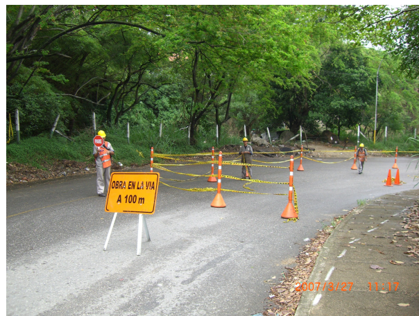
FIGURA 36. SEÑALIZACIÓN DE INICIO ACTIVIDADES DE REPARCHEO
