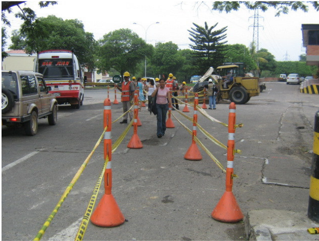
FIGURA 33. SENDERO PEATONAL EN EL PARCHEO UBICADO EN TCC
