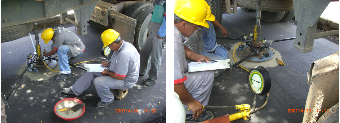
FIGURA 9. ENSAYO DE PLACA A LA MEZCLA DENSA EN CALIENTE (MDC -3)
