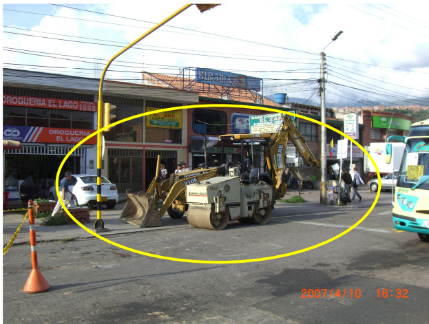
FIGURA 19. MAQUINARIA SIN SEÑALIZACIÓN Y SOBRE EL ANDÉN
