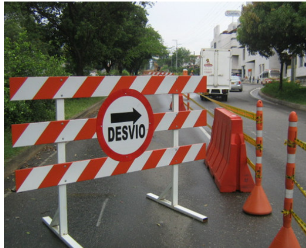
FIGURA 35. SEÑALIZACIÓN DE DESVÍO AL COMIENZO DE LA OBRA
