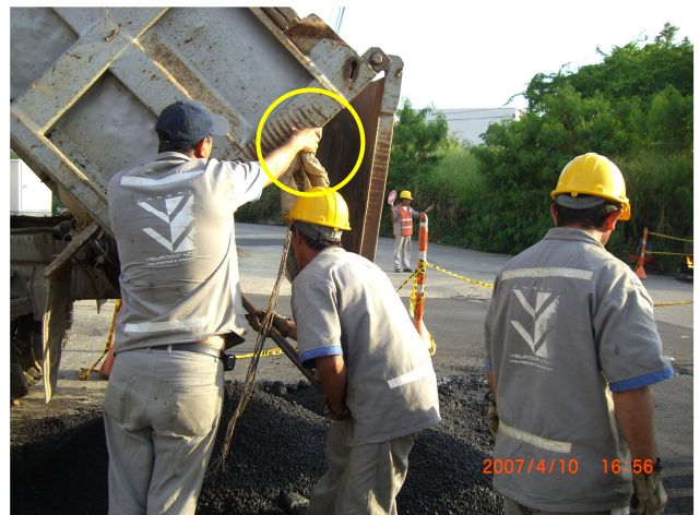
FIGURA 12. DESCARGUE DE ASFALTO A 150°C
