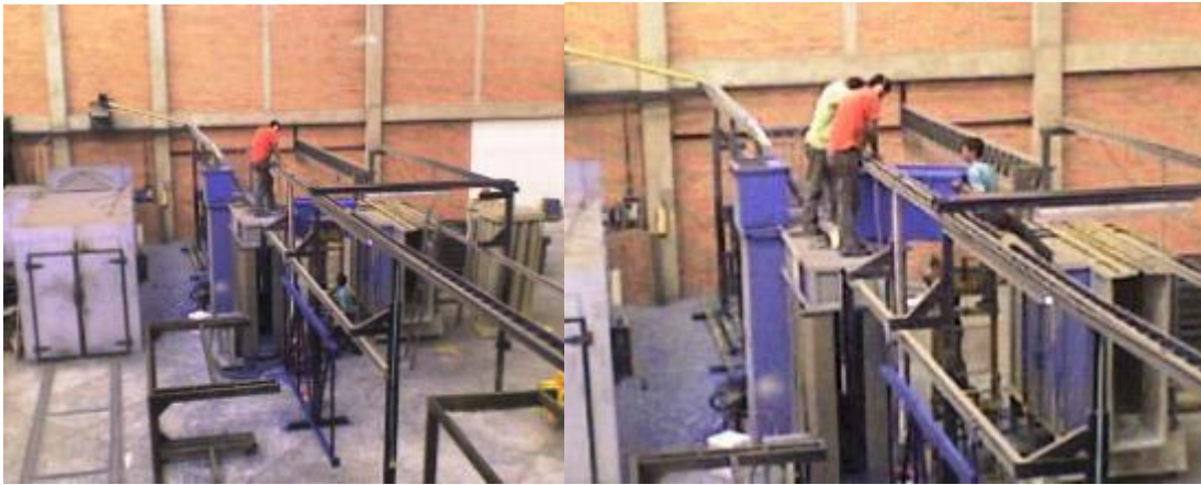
Figura No. 76 Instalación nueva turbina.
