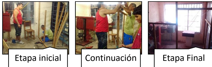
Figura 39. Construcción cuarto para la máquina terminadora.
