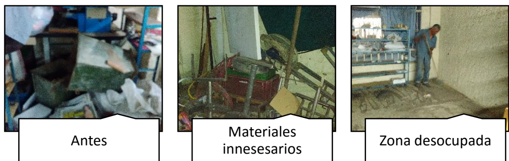
Figura 40. Despeje de área en la fábrica.
