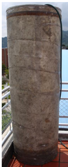
(a) Tanque en fibra de vidrio.
