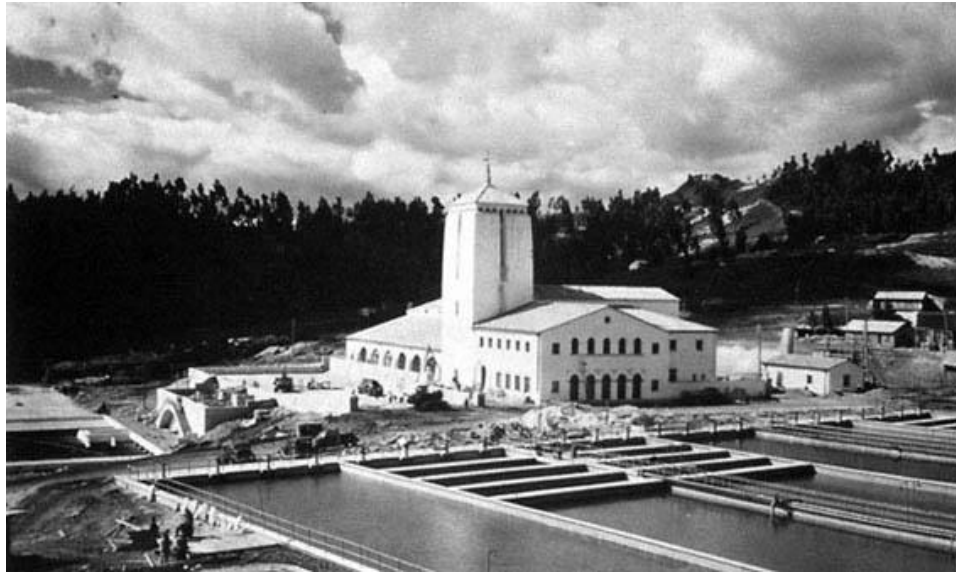
Figura 2. Planta de Tratamiento Vitelma.
