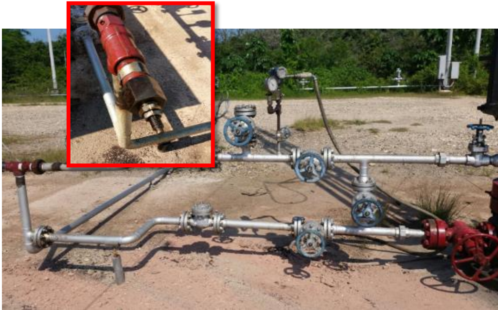
Figura 18. Instalación de la válvula BPRV
