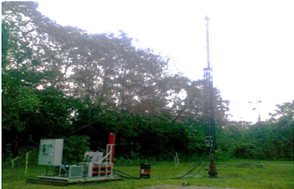
Figura 10. Unidad de bombeo alternativo
