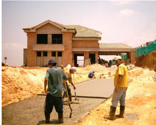
Figura 45. Corte y nivelación concreto
