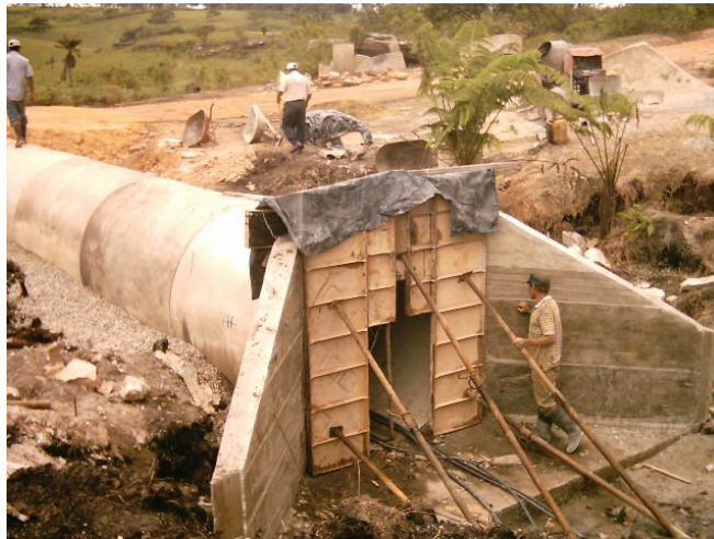
Figura 14. Box Culvert En tubería American Pipe de 67 “
