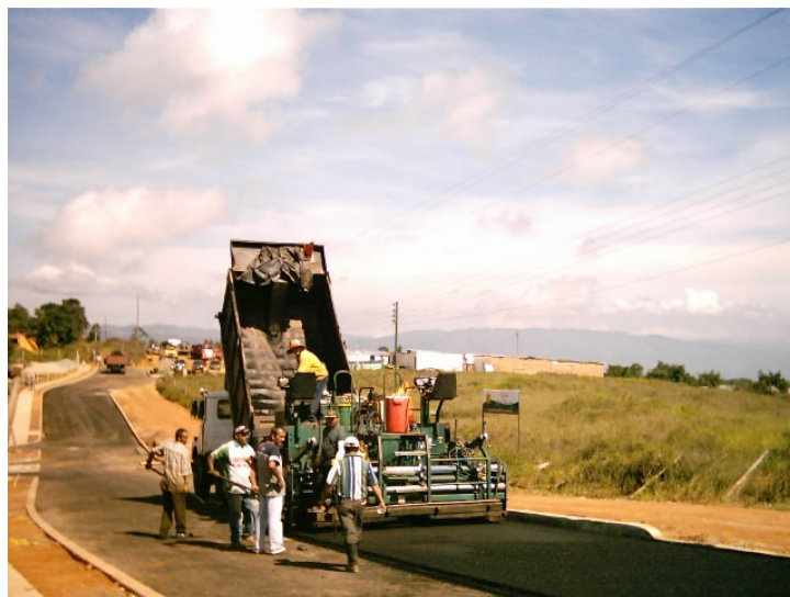
Figura 16. Ampliación malla vial, instalación de pavimento asfáltico.
