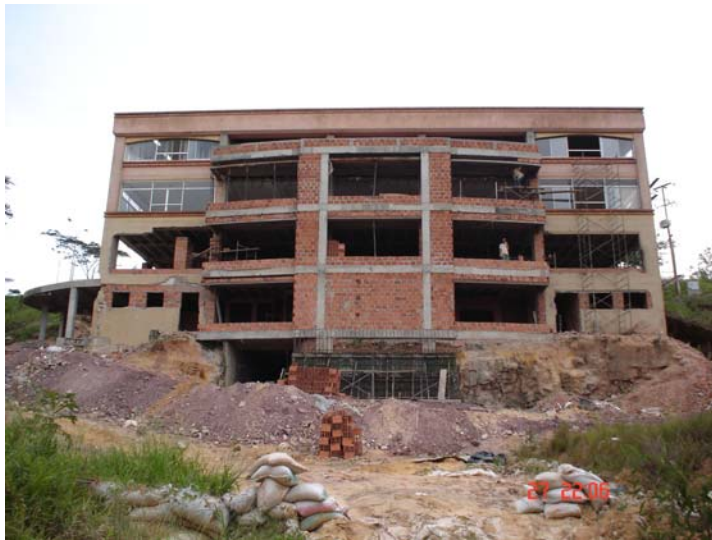
Figura 11. Vista Frontal edificio Hoyo 19
