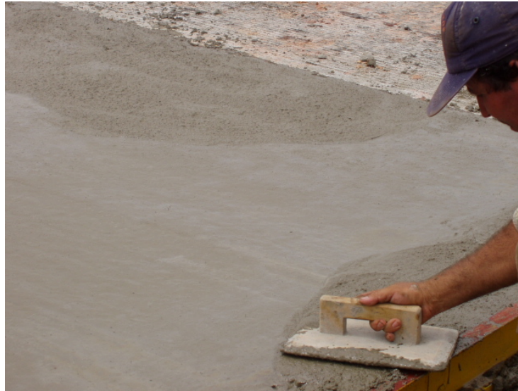
Figura 46. Allanado superficie losa
