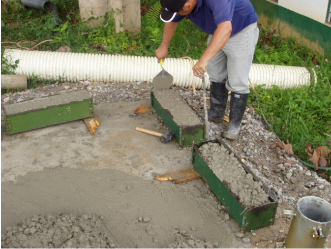
Figura 29. Curado de las muestras de concreto
