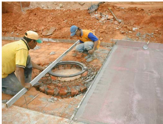
Figura 42. Detalle Hierro refuerzo vías.
