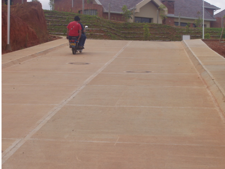
Figura 54. Detalle acabado final de vías internas Colina
