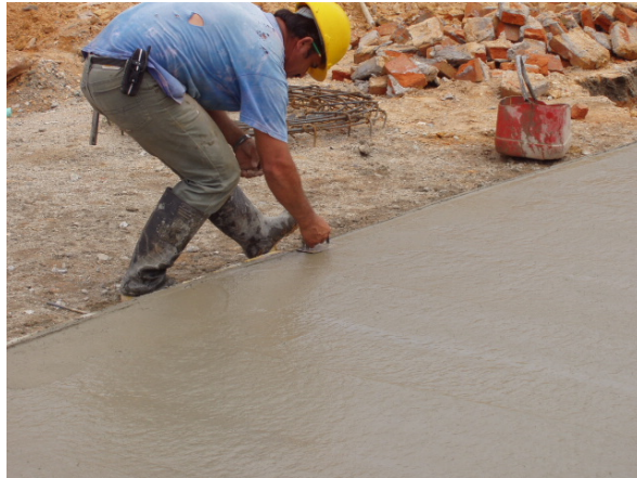
Figura 47. Biselado de los bordes de la losa
