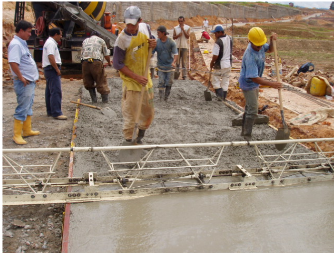
Figura 6. Detalle fundida de vías la montaña
