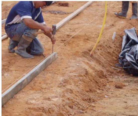
Figura 41. Colocación formaleta
