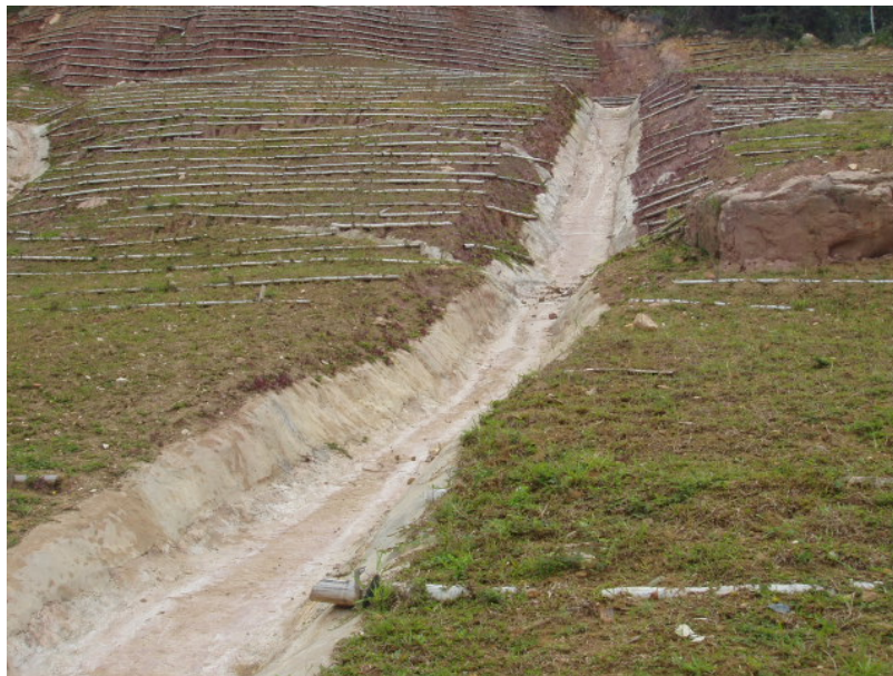
Figura 20. Canales de drenaje construidos en talud via de acceso K2+270
