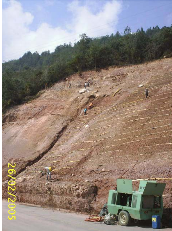
Figura 20. Canales de drenaje construidos en talud via de acceso K2+270
