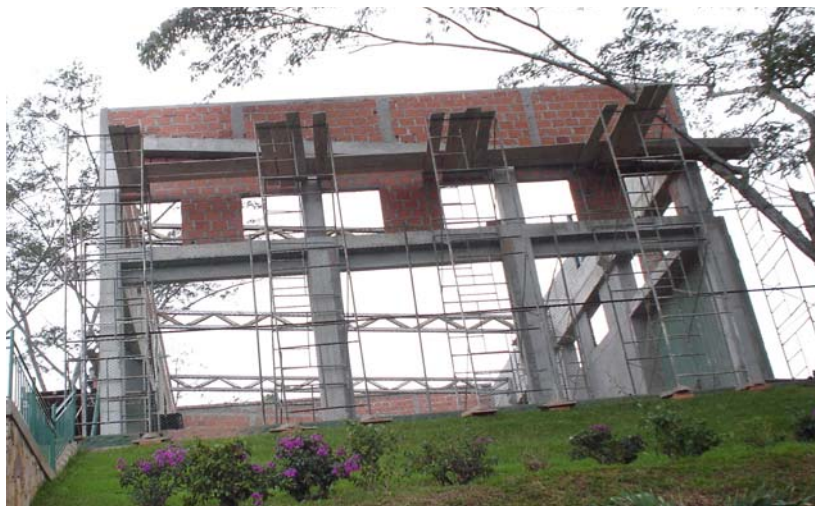
Figura 9. Vista estructura gimnasio, Hoyo 19.
