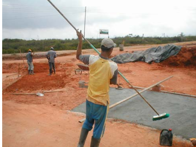
Figura 48. Texturizado realizado mediante el escobeadado.
