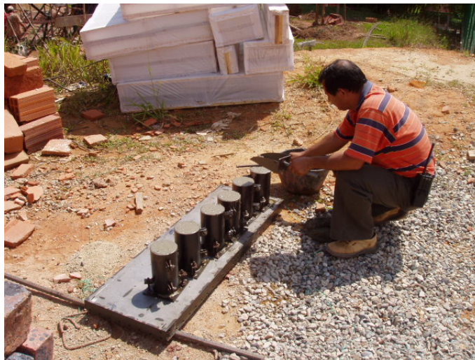
Figura 27. Toma de muestras de concreto
