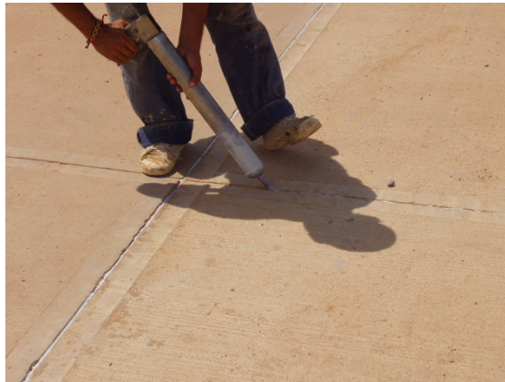
Figura 53. Aplicación del sellante. Sikaflex para juntas de vías
