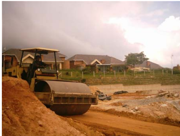
Figura 38. Movimiento tierras menor vía interna colina.
