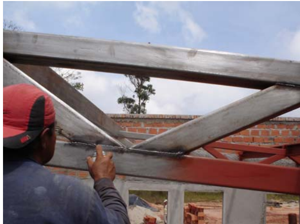
Figura 32. Aplicación de limpiador a la soldadura.
