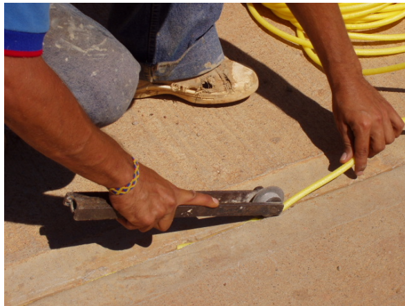
Figura 52. Instalación Sikarod en juntas de vías.
