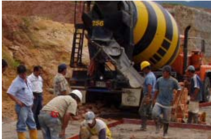
Figura 44. Descargue concreto vías
