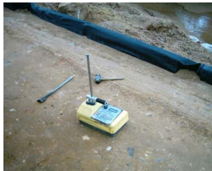
Figura 22. Ensayo de densidades con densímetro nuclear, en rellenos de muros en tierra armada.
