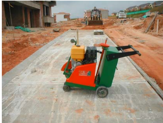
Figura 51. Cortador utilizada en los cortes de las juntas.
