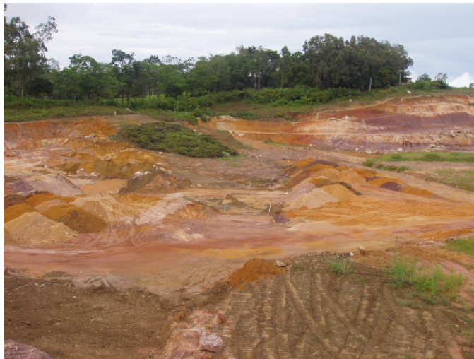
Figura 12. Vista Sitio de disposición de sobrantes.
