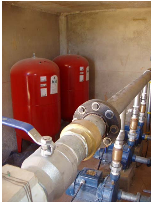
Figura 2. Sistema de presión constante, Colina de Yerbabuena
