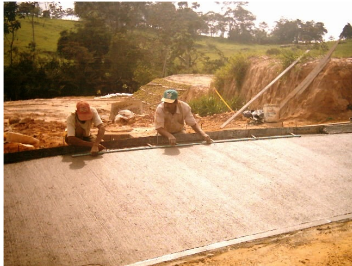
Figura 50. Detalle construcción de sardineles
