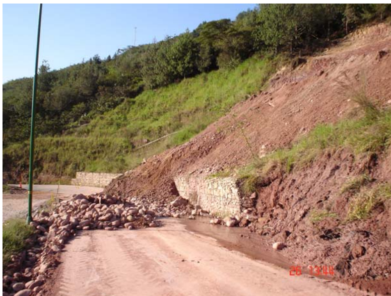
Figura 17. Derrumbe vía acceso al condominio, K2+270
