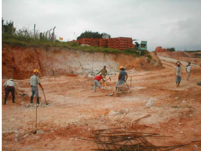
Figura 39. Cuadrilla de replanteo de vías interna colina
