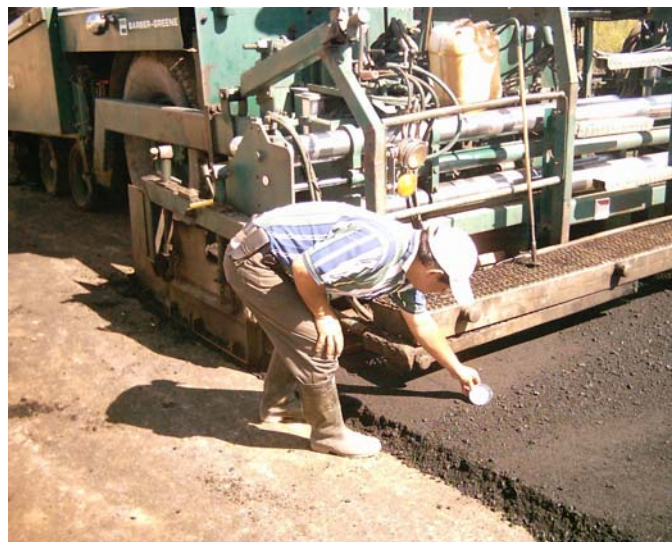
Figura 25. Control de temperatura al pavimento extendido.
