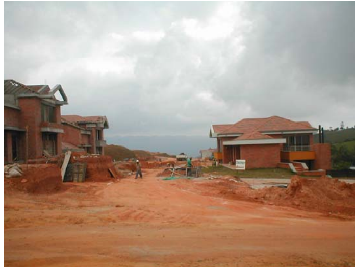
Figura 1. Vista Obra Colina de Yerbabuena, vía 1.
