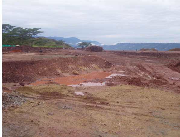
Figura 7. Detalle Movimiento de tierras loma puyana
