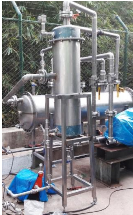
Figura 32. Tanque de recirculación y estructura ya instalados.
