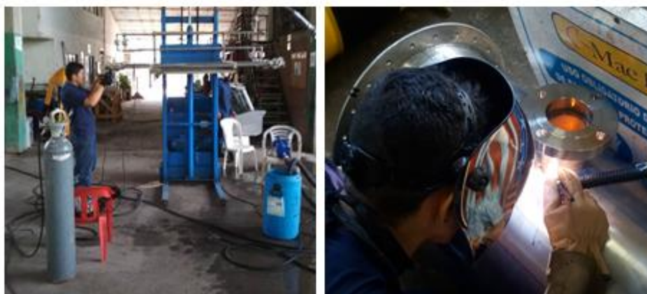
Figura 43. Corrección de las fugas identificadas.
