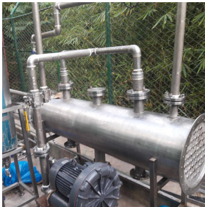
Figura 23. Evaporador-Condensador construido, en proceso de instalación en la planta.
