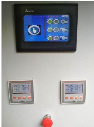
Figura 38. Pantalla Delta, multímetros Lovato y botón de emergencias en la puerta del gabinete de control
