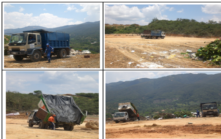
Figura 44. Llegada de volquetas y descargue de material.
