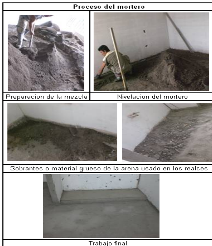
Figura 21. Proceso del mortero de nivelación.
