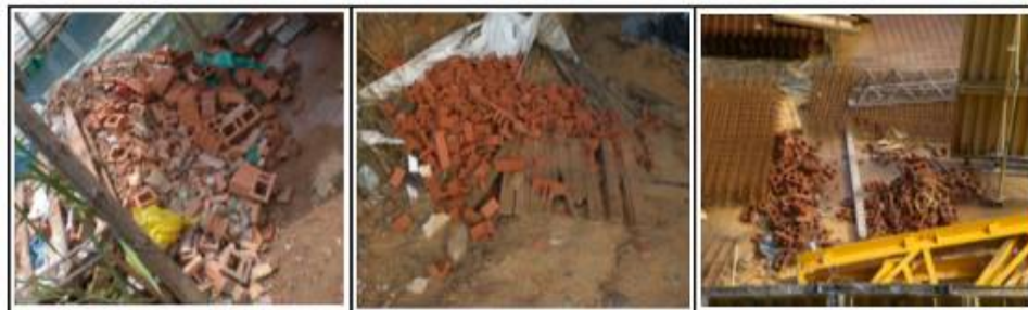
Figura 7. Escombros de mampostería en limpio.
