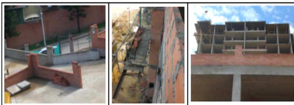
Figura 5. Ejemplos de mampostería a la vista.
