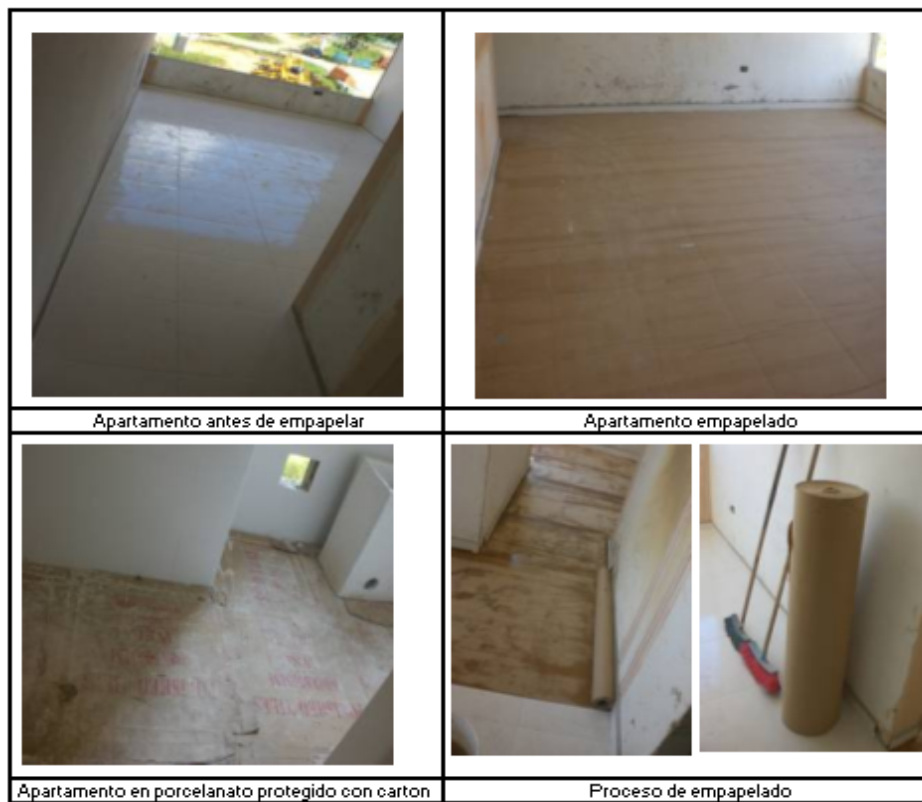
Figura 24. Protección de la loza de piso con papel.
