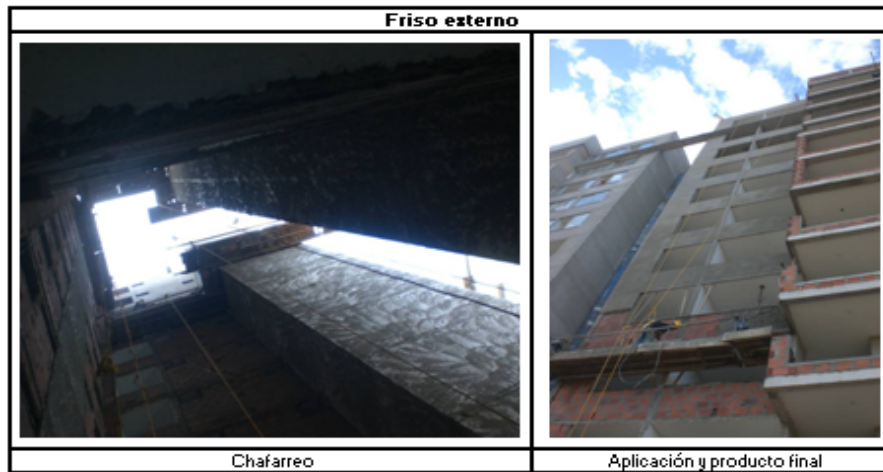
Figura 12. Proceso del friso externo
