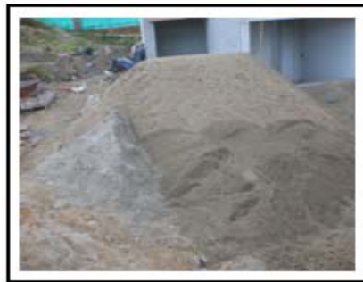
Figura 22. Almacenamiento de arena enfrente de la torre que se va morterear.
