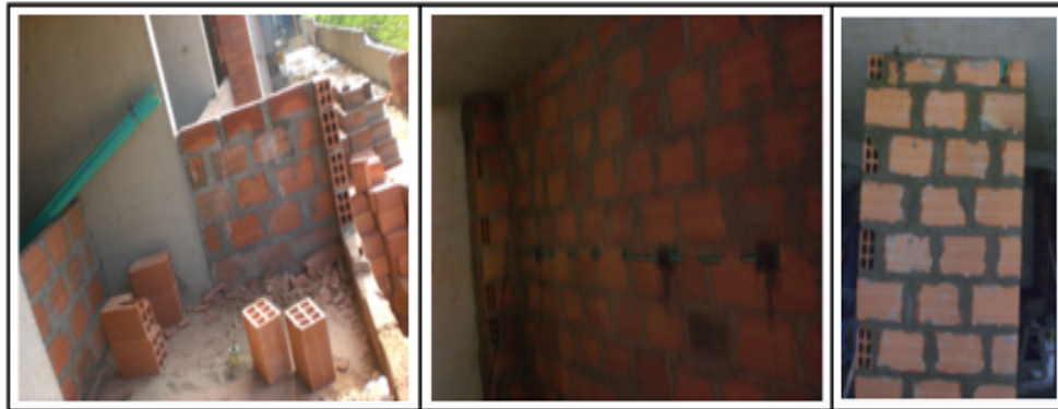
Figura 1. Muros de mampostería en sucio antes de ser frisados.
