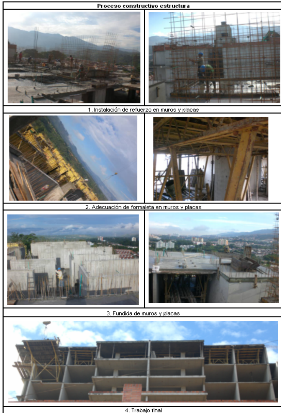
Figura 14. Proceso constructivo de la estructura.
