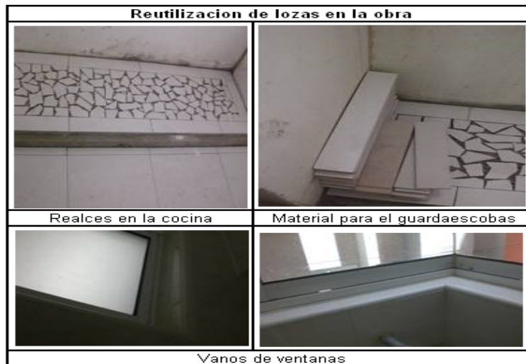
Figura 28. Reutilización de lozas en la obra.
