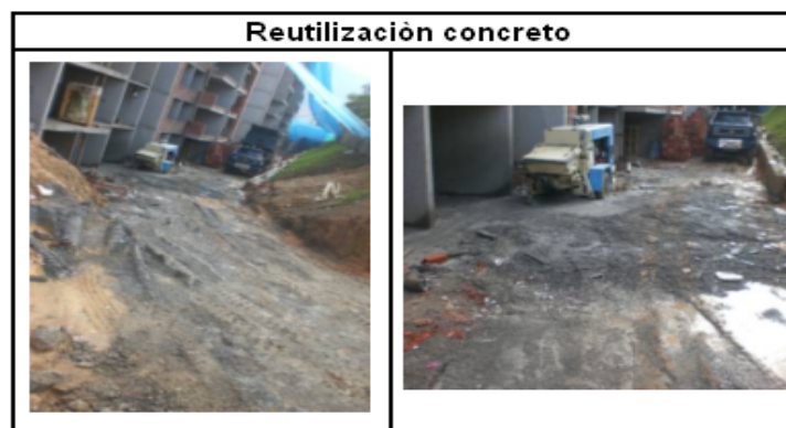
Figura 18. Reutilización dada al concreto en la obra.
