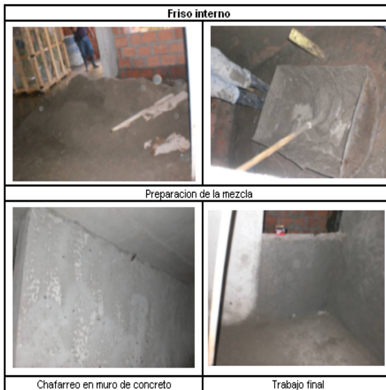
Figura 11. Proceso del friso interno.
