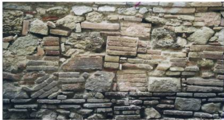
Iglesia de Barcelona rehabilitada con residuos procedentes del derribo de otros edificios.
