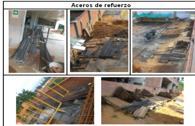
Figura 16. Aceros de refuerzo para muros y placas.
