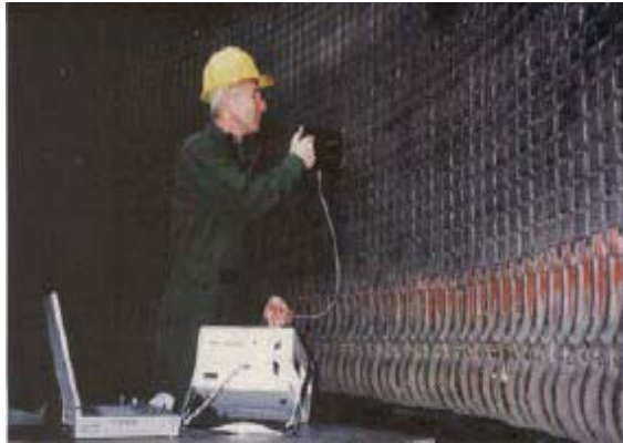
Figura 169. Revisión de chapas de un estator
