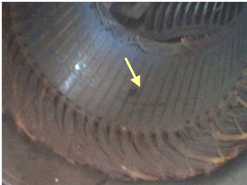
Figura 164. Inspección de esta zona estrecha del motor
