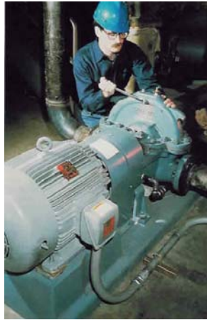
Figura 165. Desacople del motor de la carga impulsada
