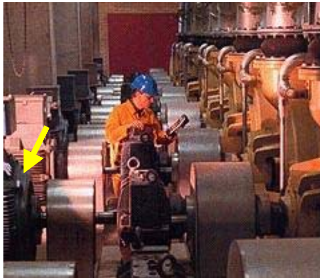
Figura 65. Aplicación de los motores eléctricos en la industria metalúrgica
