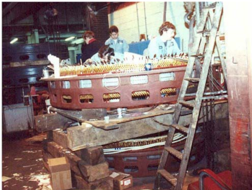
Figura 285. Mantenimiento en el estator
