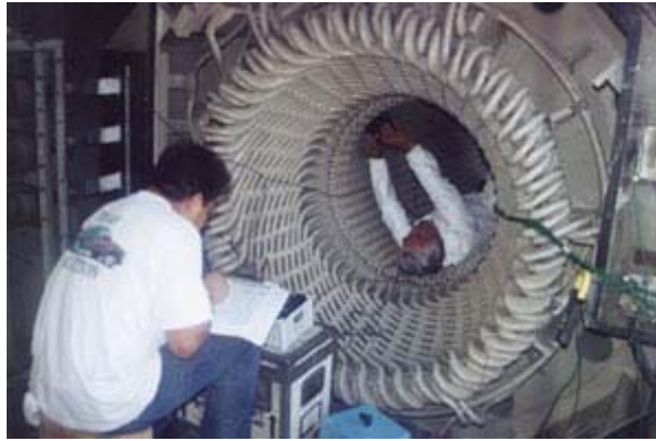
Figura 277. Revisión de conexiones del bobinado
