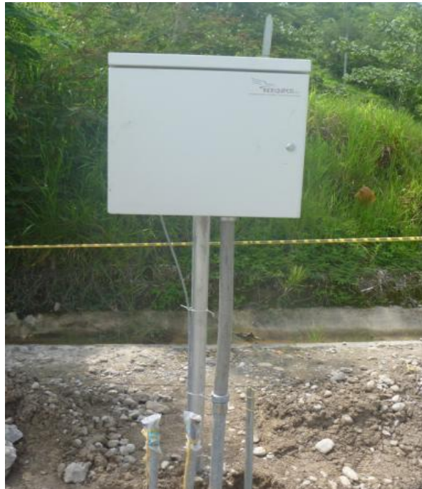
Figura 32. Instalación del gabinete SAM
