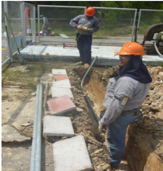
Figura 25. Instalación de la tubería en el Campo Lisama 86
