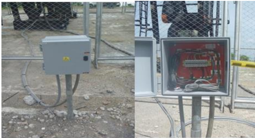
Figura 33. Instalación y conexiones de la caja de paso en el Campo Nutria 37
