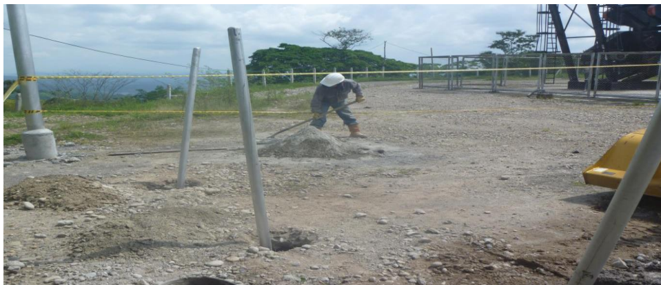
Figura 29. Excavación e instalación del mástil del SAM en el Campo Nutria 37
