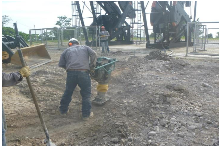
Figura 31. Relleno y Compactación en el Campo Nutria 37
