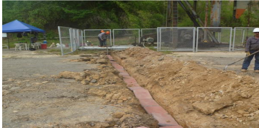
Figura 26. Instalación de las placas de mineral rojo en el Campo Lisama 86
