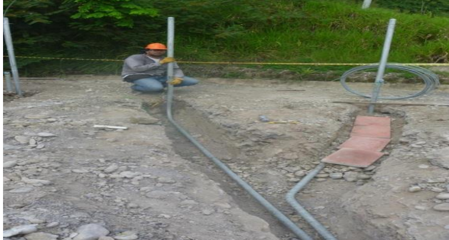
Figura 30. Instalación de tubería en el Campo Nutria 37
