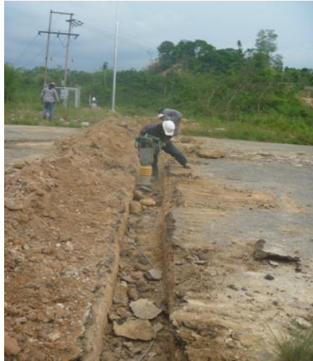
Figura 28. Relleno y Compactación en el Campo Lisama 86
